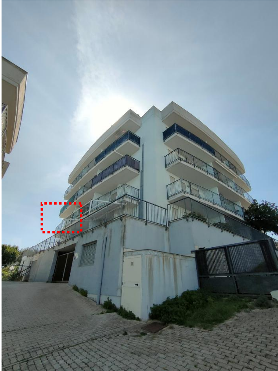
Vista Esterna Edificio in Via Belvedere n. 6/A – Tortoreto (TE) Piano Primo – Interno n. 10
