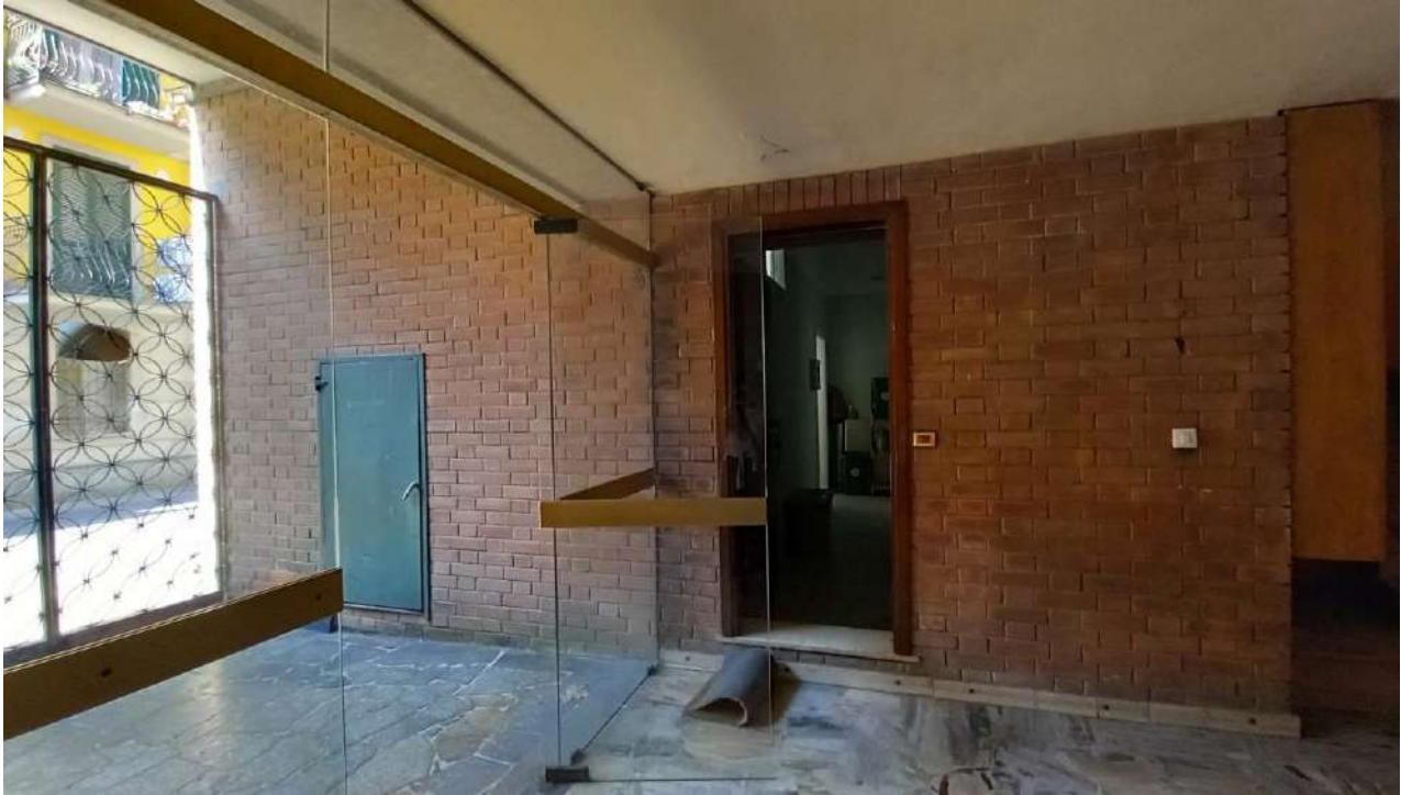
Foto 3 – Vista ingresso da retro su Via 1821
