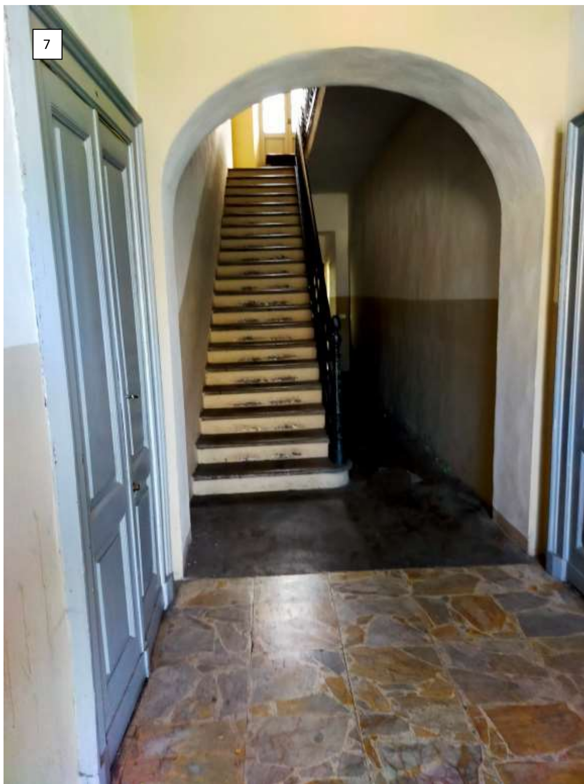
vano scala comune
