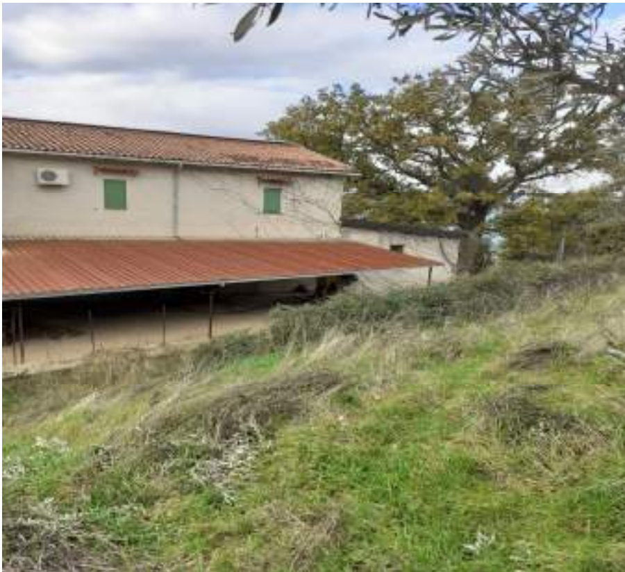
PART 458 VISTA LATO EST TETTOIA
