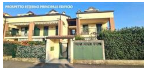
PROSPETTO PRINCIPALE EDIFICIO
