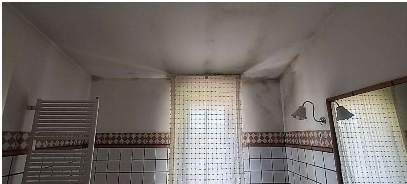
Foto nr. 13 - Bagno Piano Primo - Bene 1
