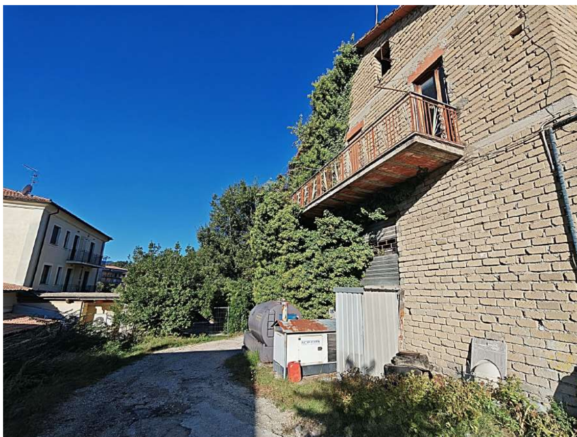
Foto nr. 2 - Vista esterna
