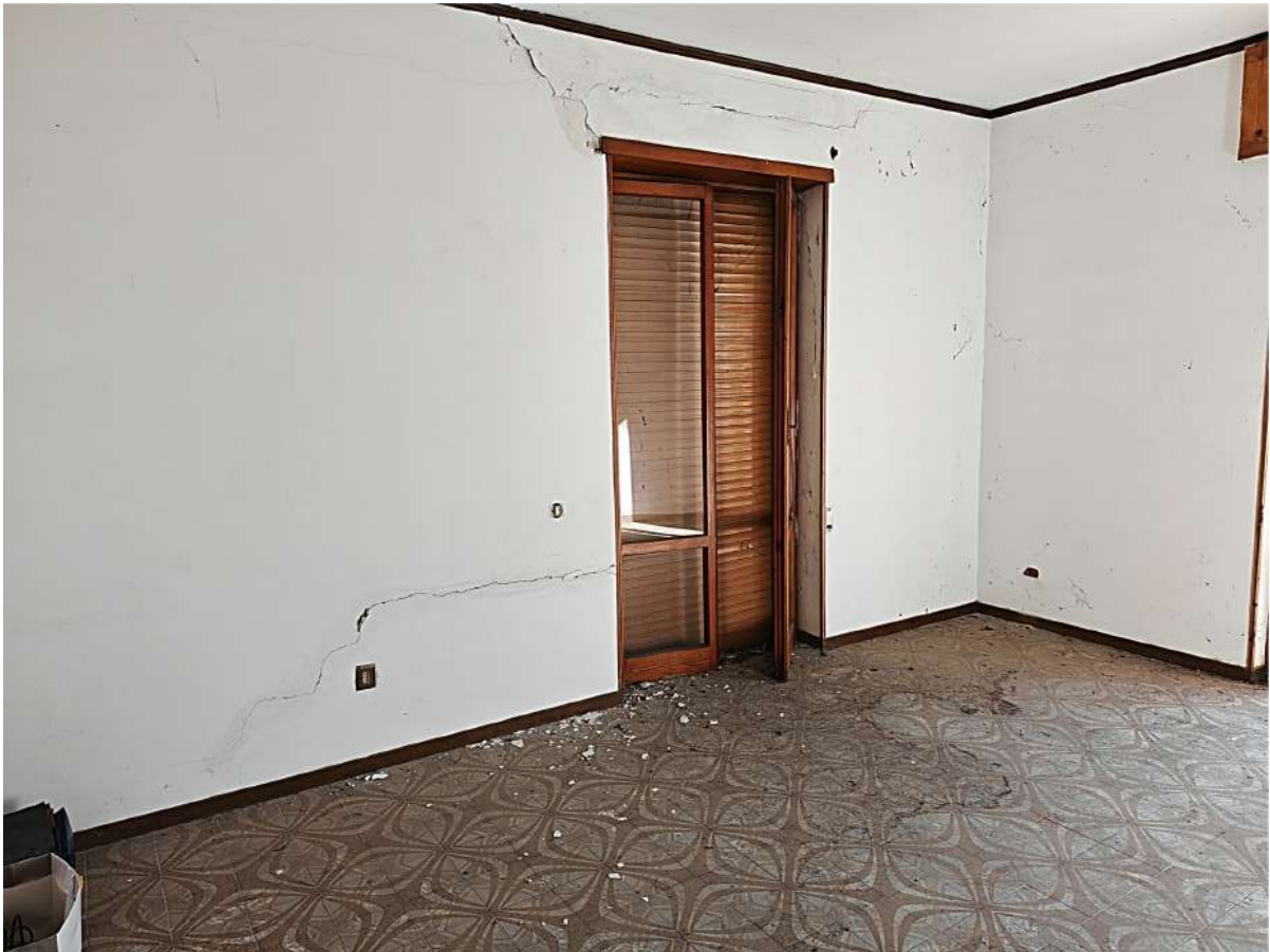
Foto nr. 11 - Appartamento Piano Primo -Bene 5-
