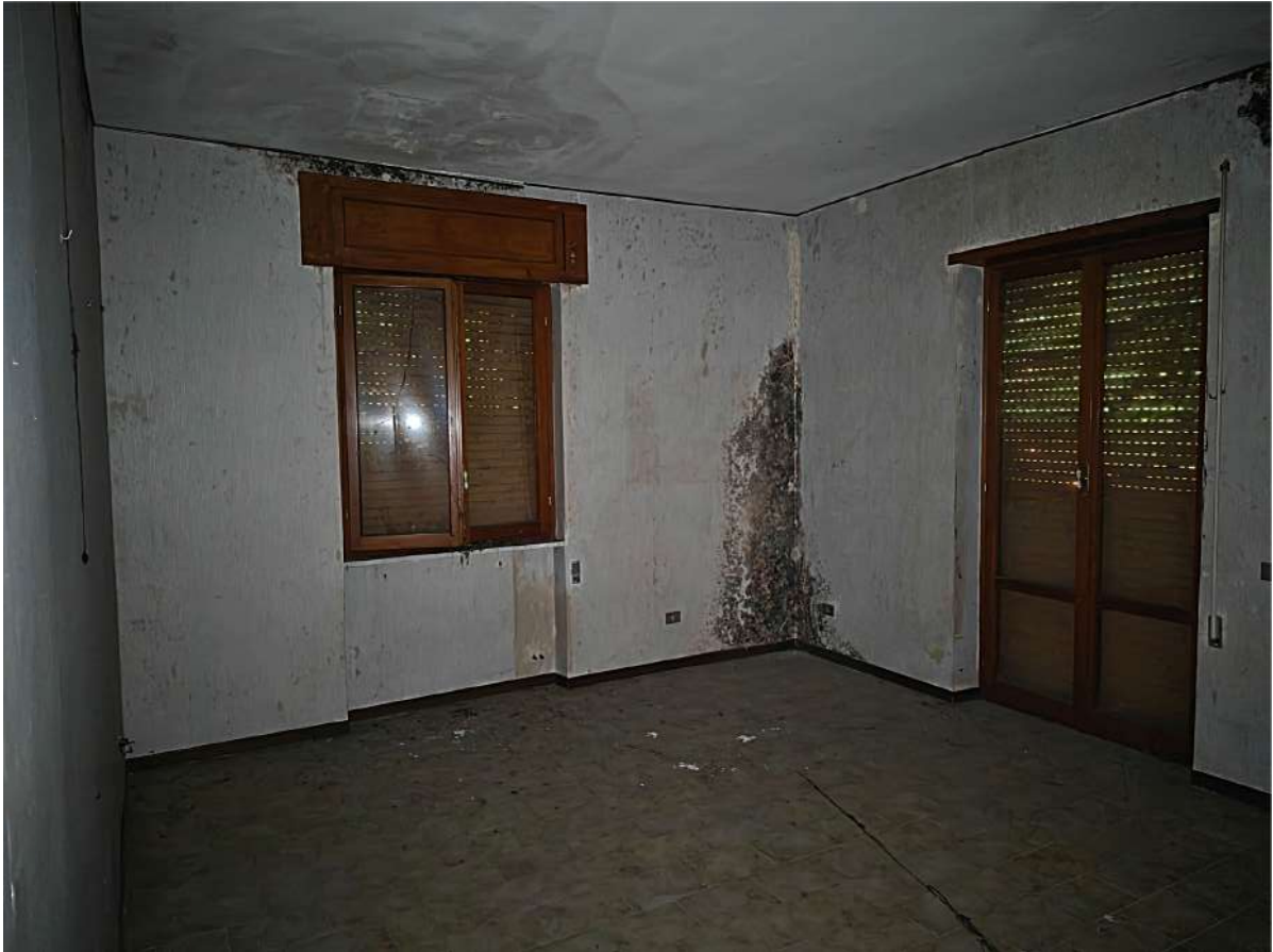
Foto nr. 13 - Appartamento Piano Primo - Bene 7-
