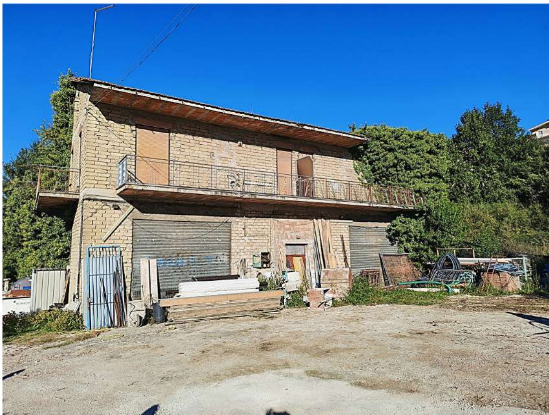
Foto nr. 1 - Vista esterna
