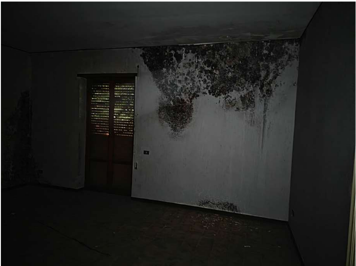
Foto nr. 12 - Appartamento Piano Primo -Bene 7-
