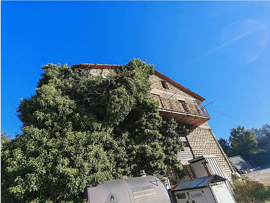
Foto nr. 3 - Vista esterna
