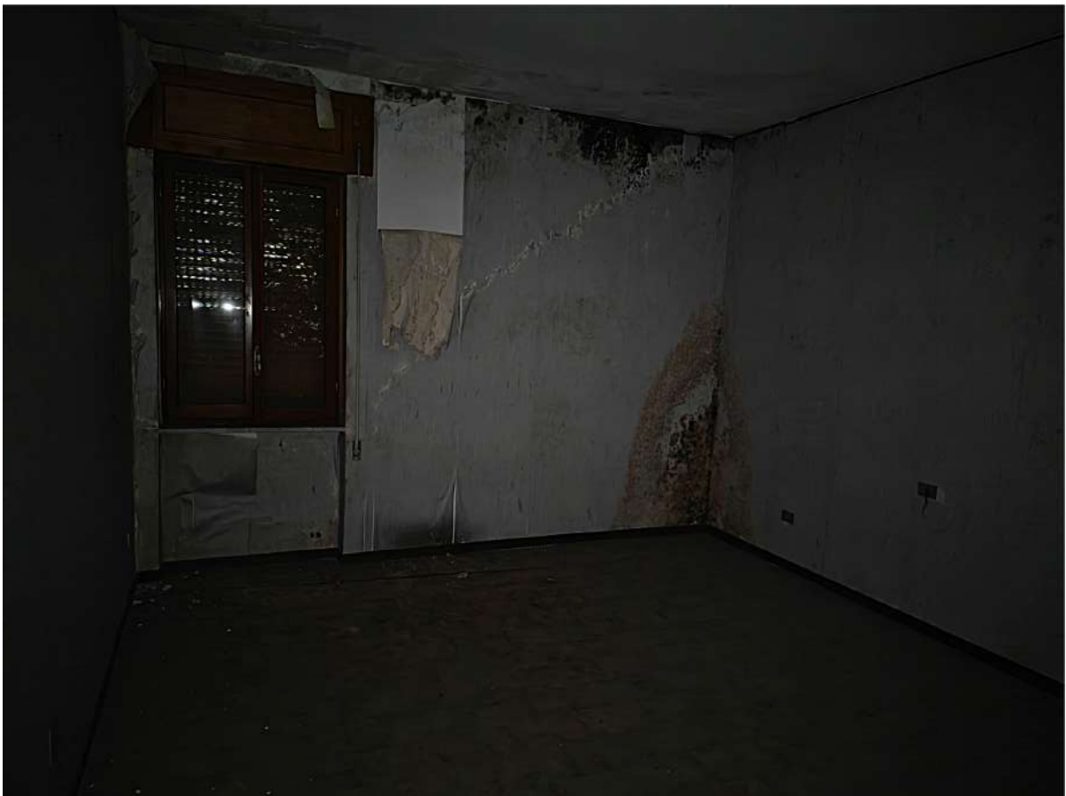
Foto nr. 14 - Appartamento Piano Primo - Bene 7-
