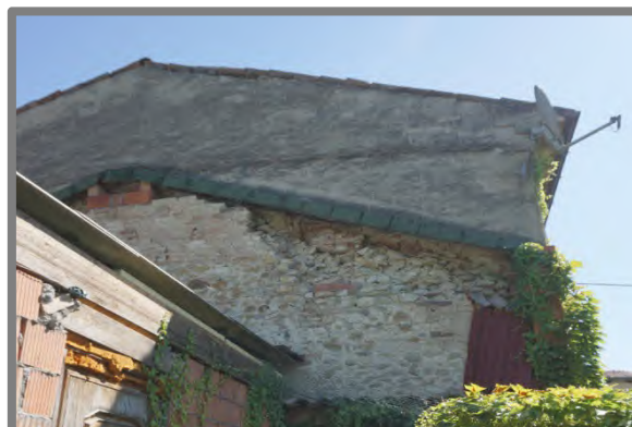
FOTO 3 – LATO SUD - EST
