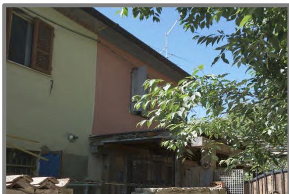
FOTO 4 – LATO NORD – OVEST
