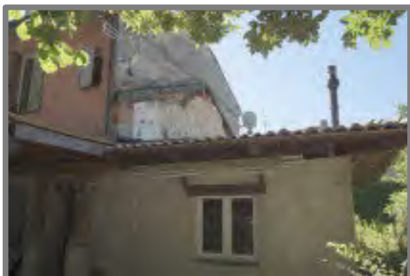
FOTO 2 – LATO NORD – OVEST
