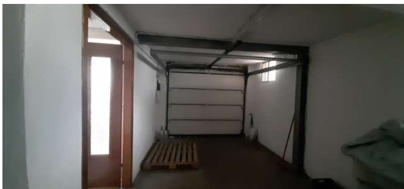
foto 2: vista interna del box
