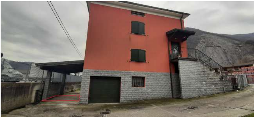
foto 2: identificazione della tettoia
