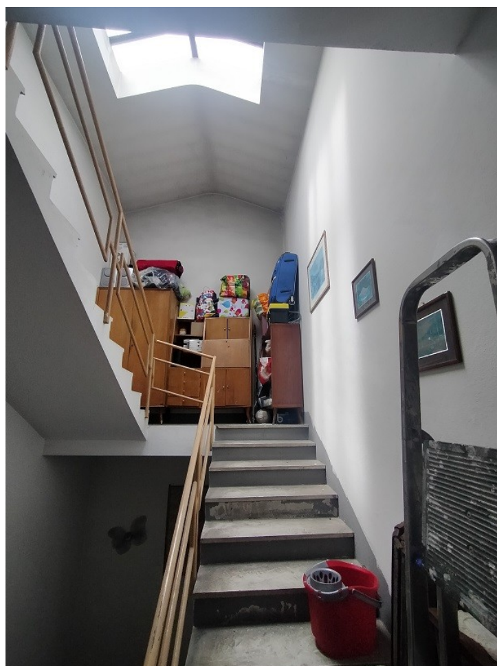
- RAMPA DI SCALE CONDOMINIALE PER IL SOTTOTETTO -
