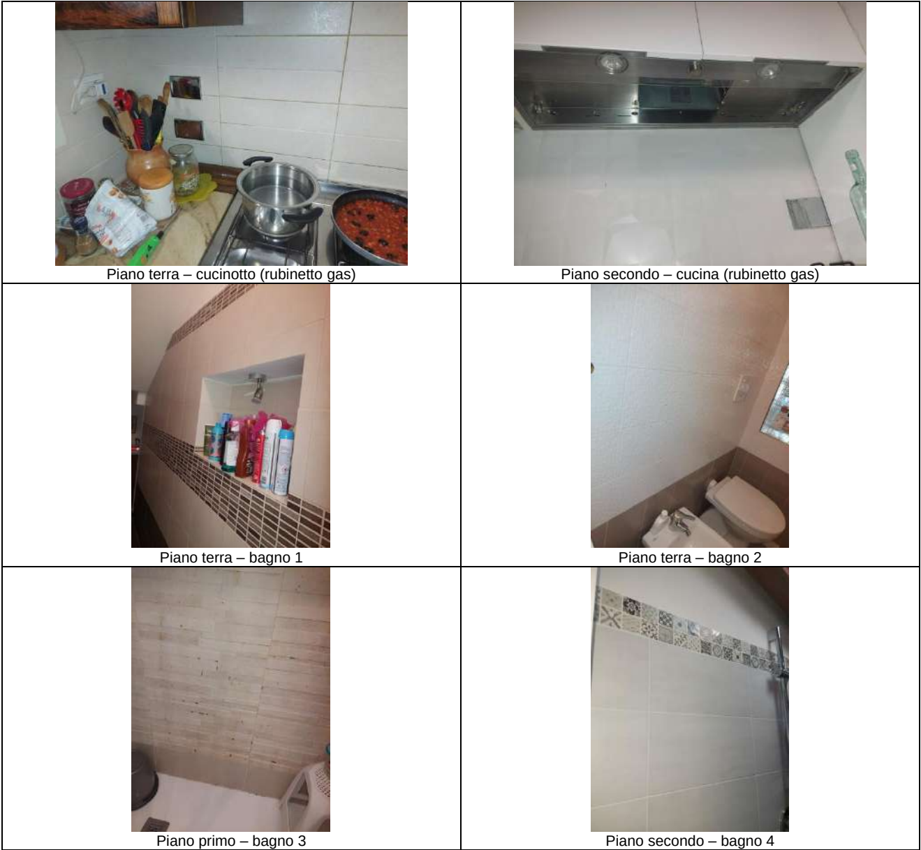
Foto 95: Rivestimenti bagni, cucina e cucinotto
