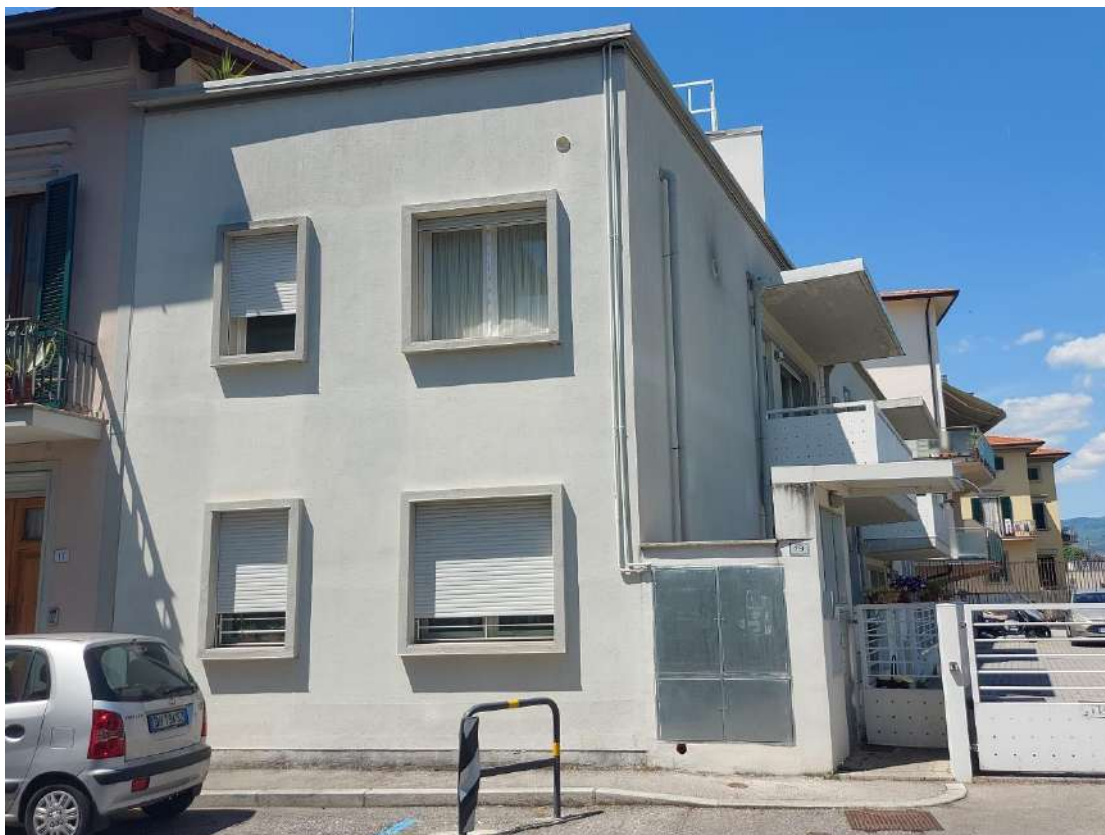
Foto 6: Via Della Robbia – facciata principale ristrutturata
