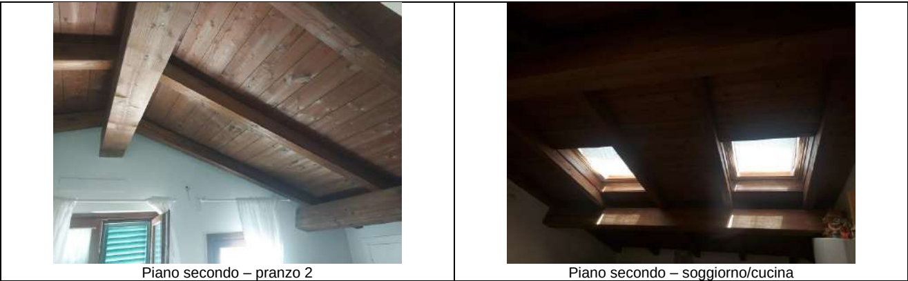
Foto 94: Solai di copertura
