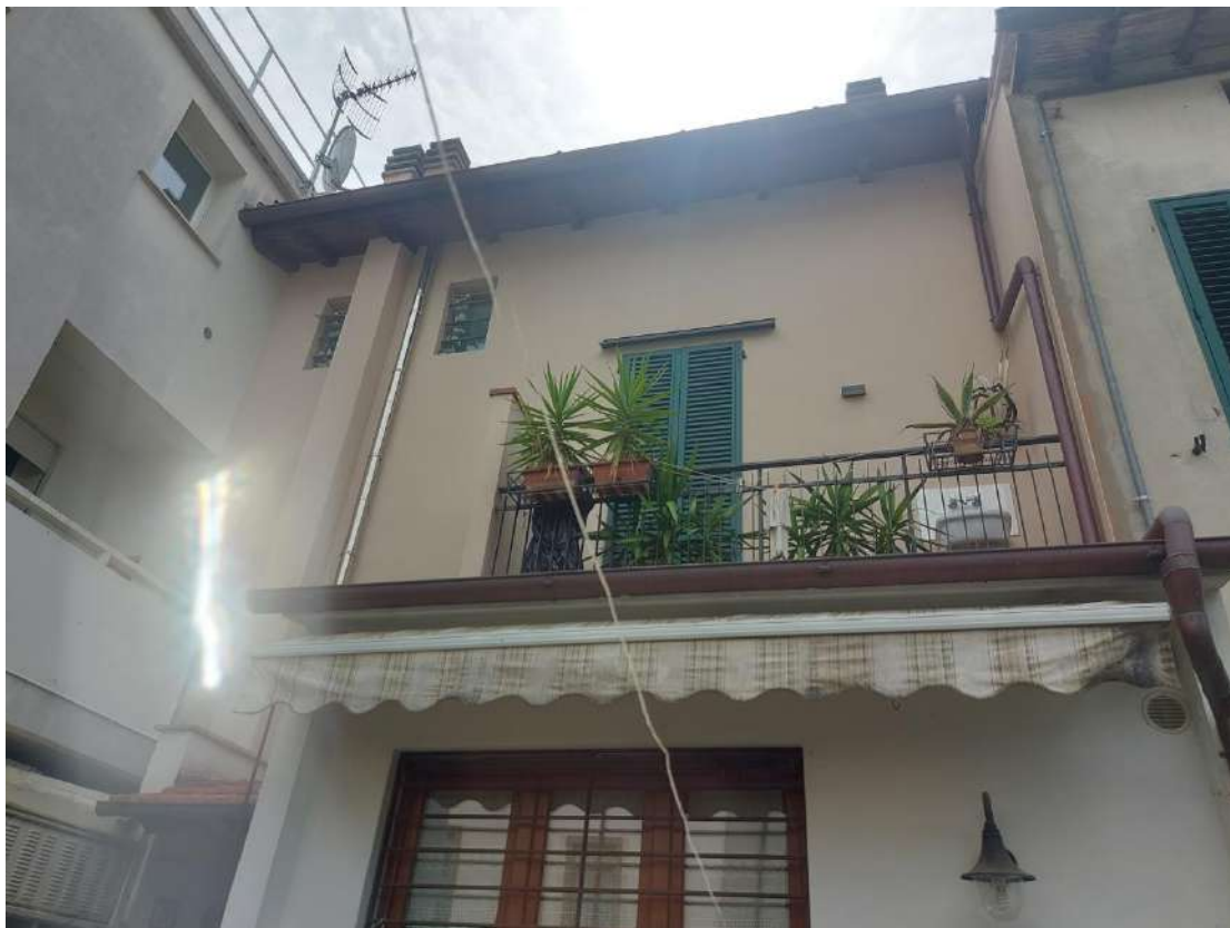
Foto 87: piano terra – resede tergale – balcone 2
