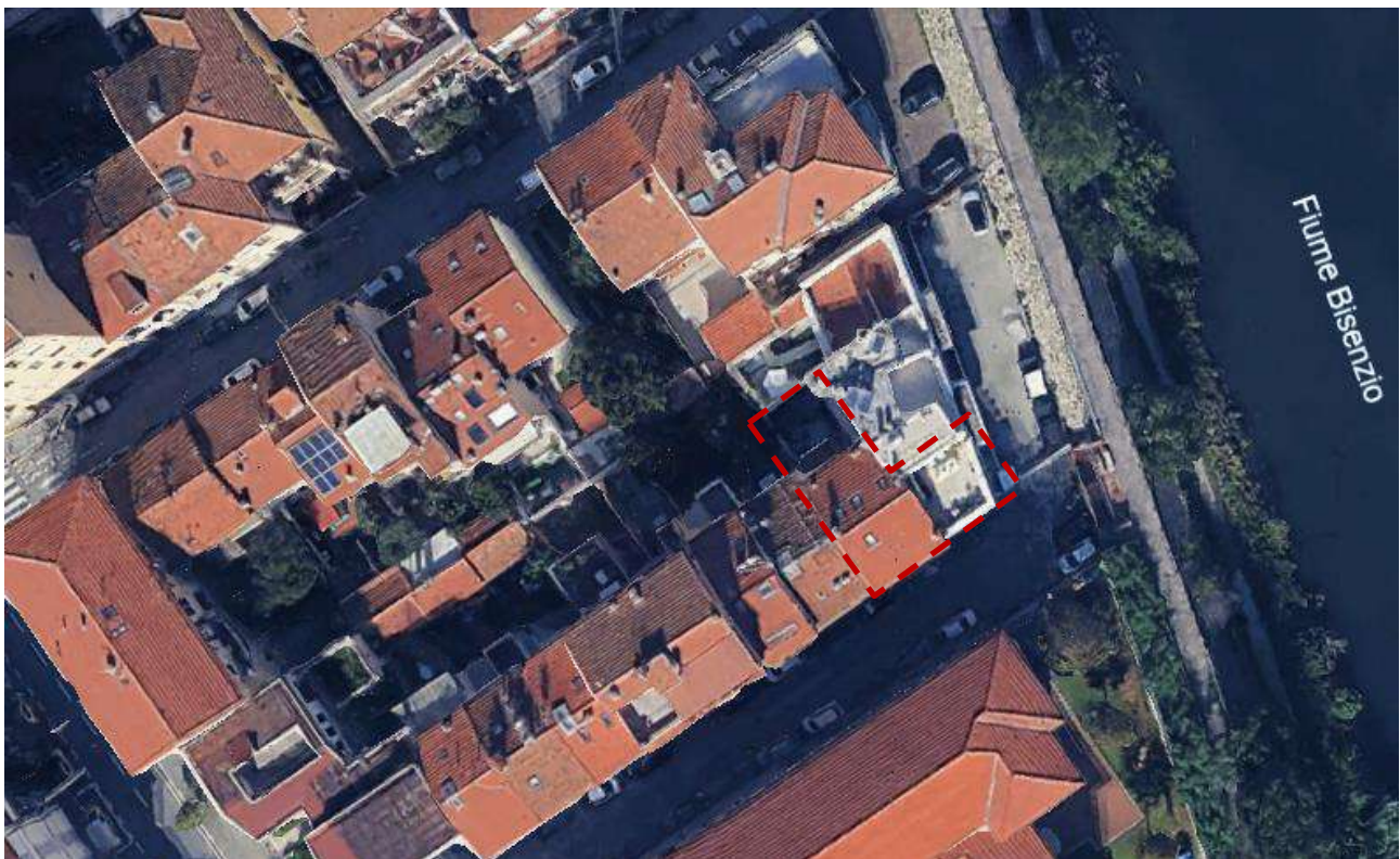
Foto 2: vista satellitare del fabbricato Particella 123
