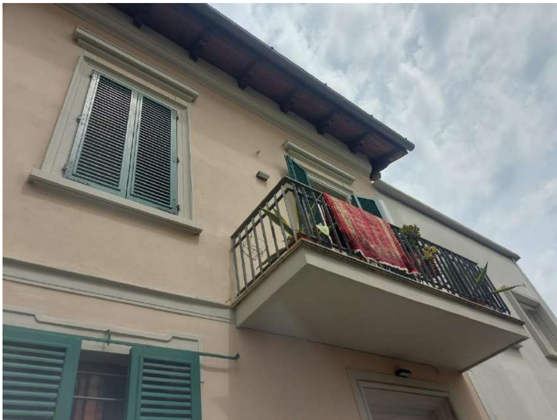
Foto 5: Via Della Robbia – facciata principale – balcone 1
