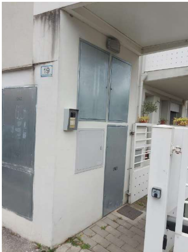
Foto 7: Via Della Robbia – civico n.19 – accesso condominiale
