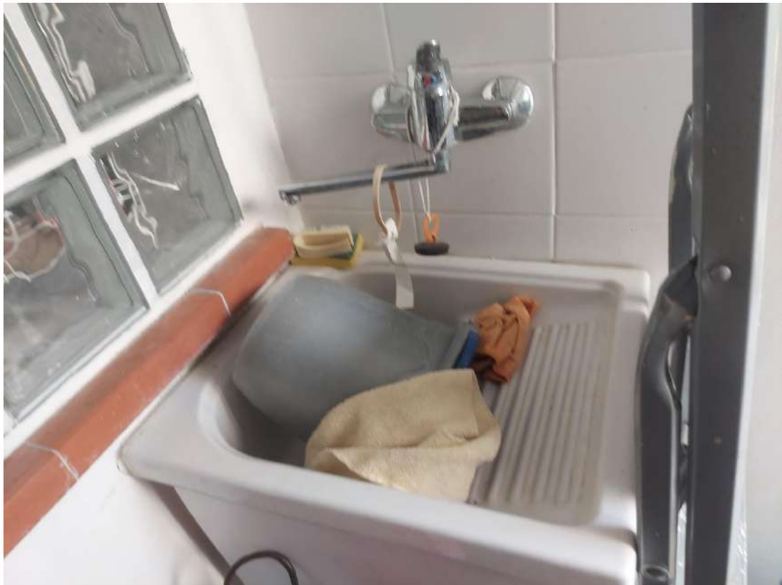
Foto 79: piano terra – disimpegno 3 - pilozzo
