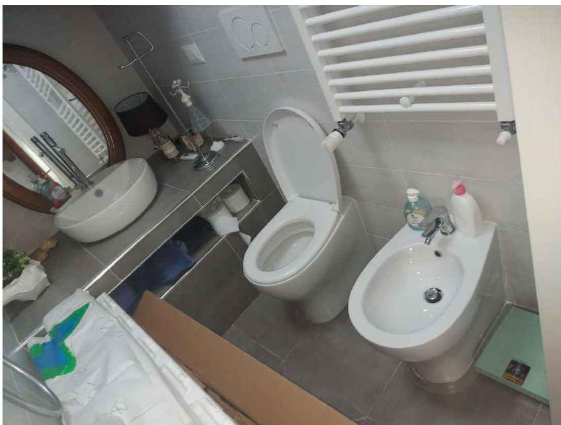
Foto 28: piano secondo – bagno 4
