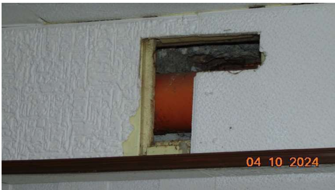
Lotto n. 2 - Foto 26 – Particolare servitù da impianti
