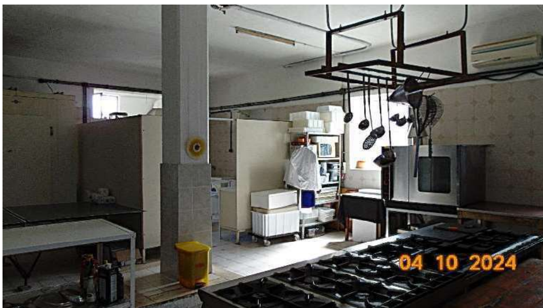
Lotto n. 2 - Foto 11 – Particolare cucina
