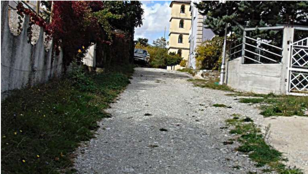
Lotto n. 2 - Foto 1 – Strada privata di accesso
