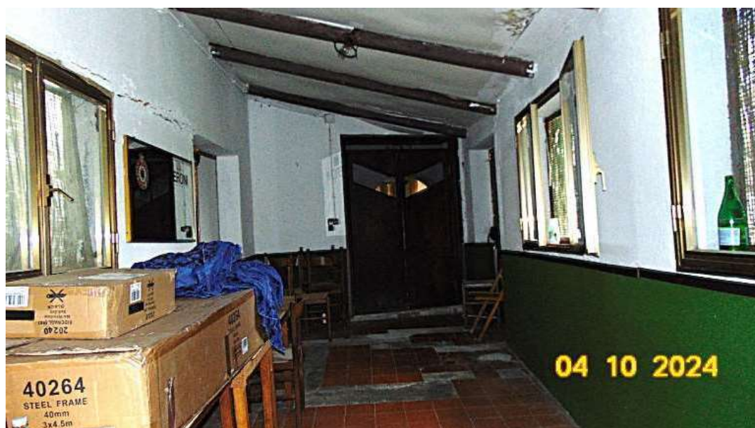
Lotto n. 2 - Foto 14 – Disimpegno accesso ristorante
