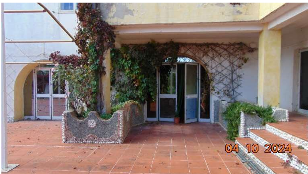
Lotto n. 2 - Foto 17 – Ingresso
