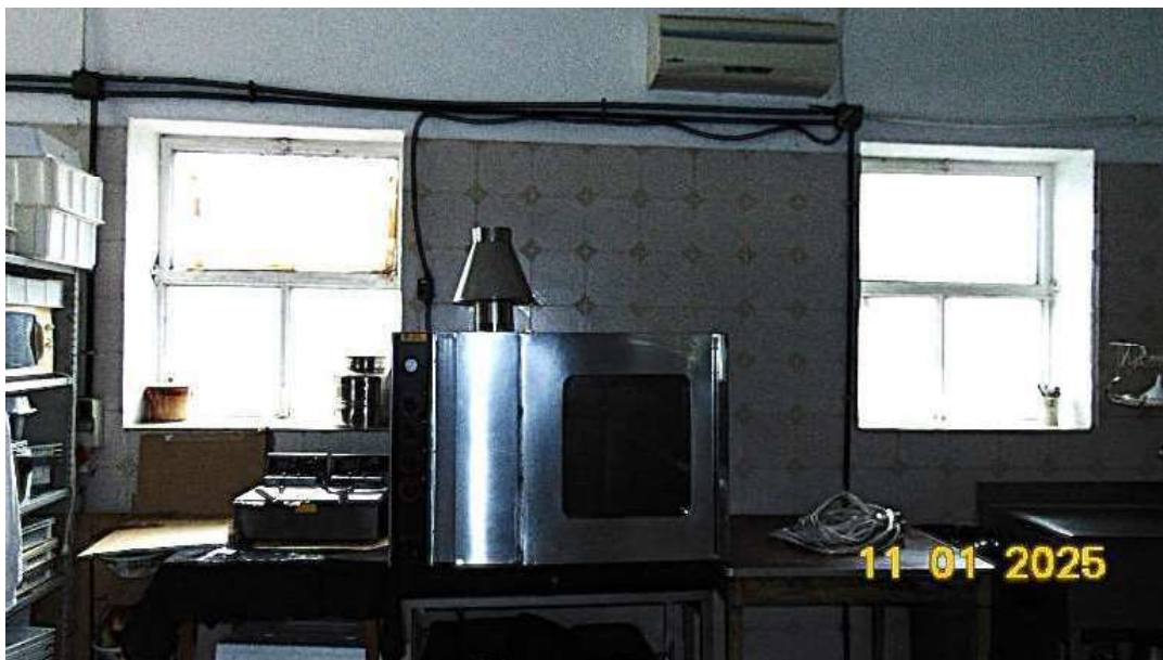
Lotto n. 2 - Foto 7 – Particolare finestre
