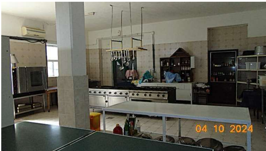
Lotto n. 2 - Foto 10 – Particolare cucina
