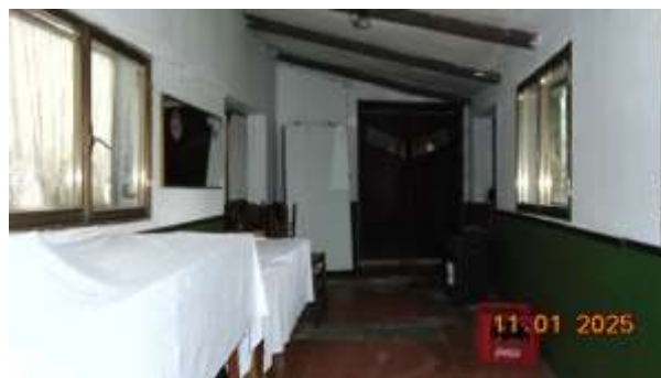
Foto n. 4 – Interno locale commerciale
