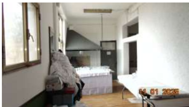
Foto n. 3 – Interno disimpegno (vista forno/deposito)
