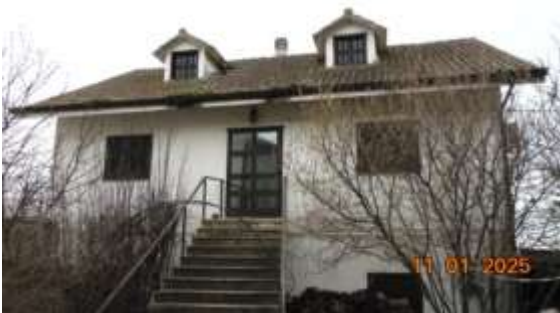
Foto n. 1 – Ingresso abitazione (scala esterna)
