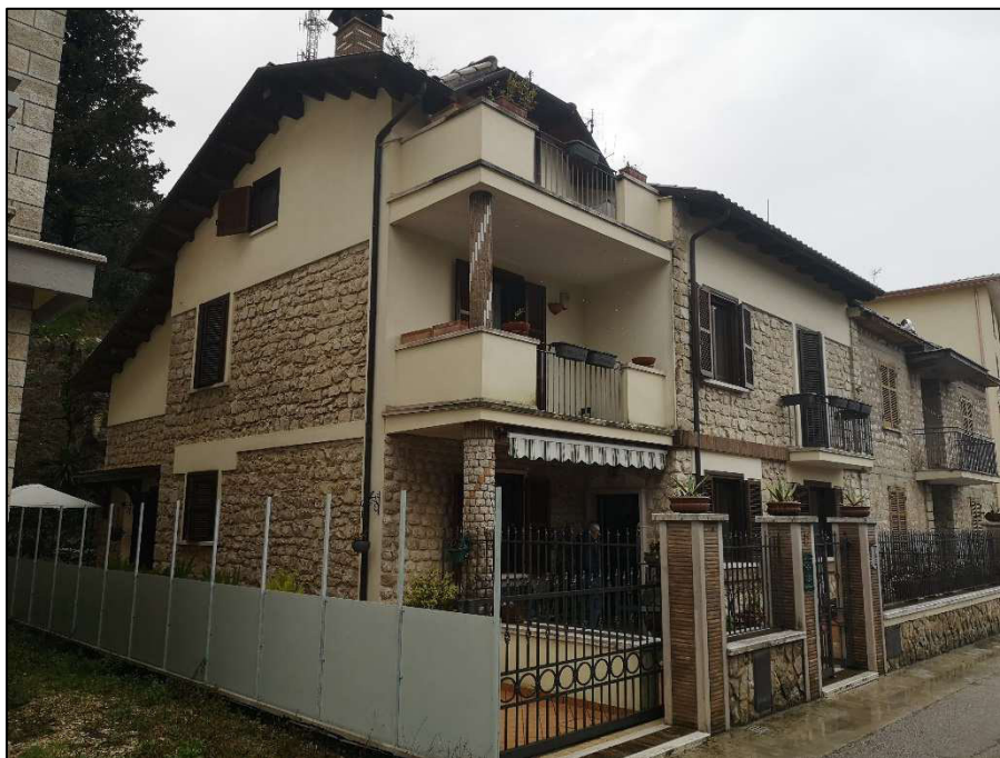
Foto 1 – Prospetto principale e prospetto Sud
