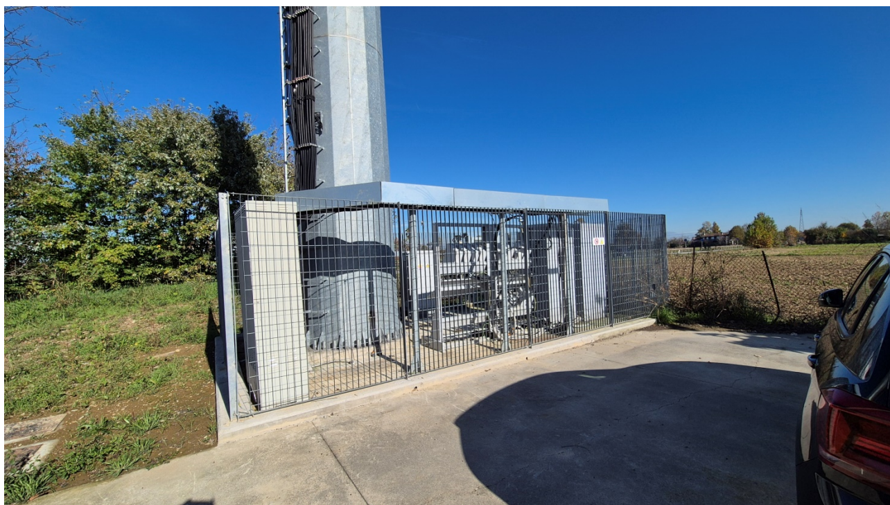
VISTA AREA CEDUTA IN DIRITTO DI SUPERFICIE
