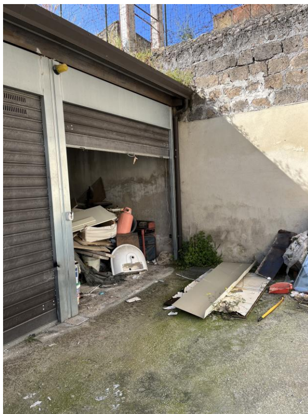
PORTA DI INGRESSO DEL BOX AUTO
