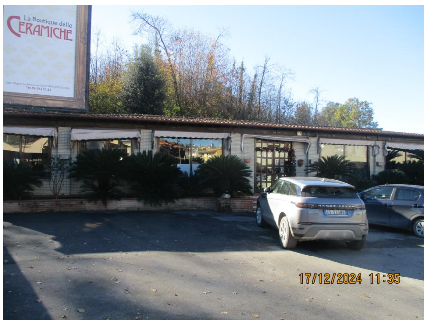
Vista esterna d'insieme dell'immobile di "minor consistenza"
