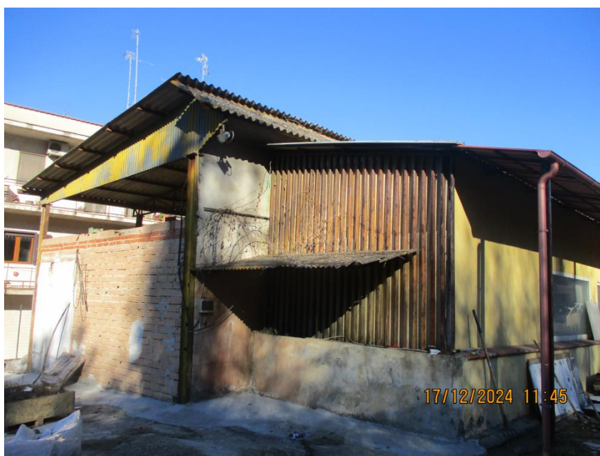
Vista esterna dei manufatti " posticci ", irregolari da rimuovere
