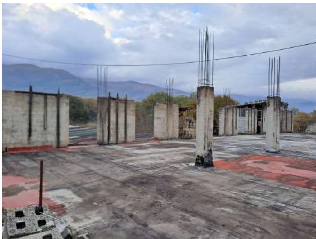
Fig. 27_ Foto interna manufatto_Corpo 10_lastrico solare P.2
