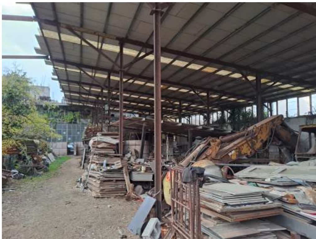
Fig. 28_ Foto interna manufatto_Corpo 2
