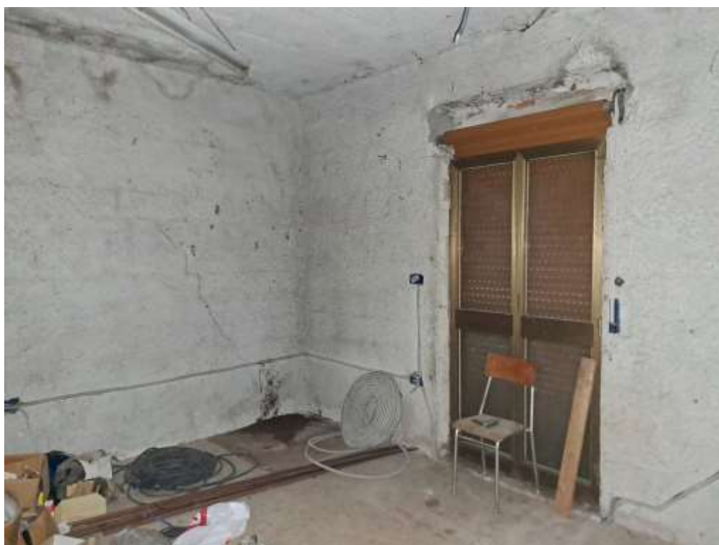
Fig. 25_ Foto interna manufatto_Corpo 9_unità in corso di costruzione P.1
