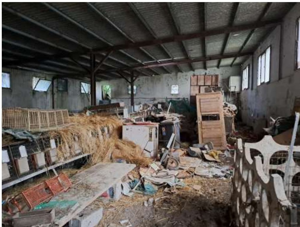
Fig. 29_ Foto interna manufatto_Corpo 5
