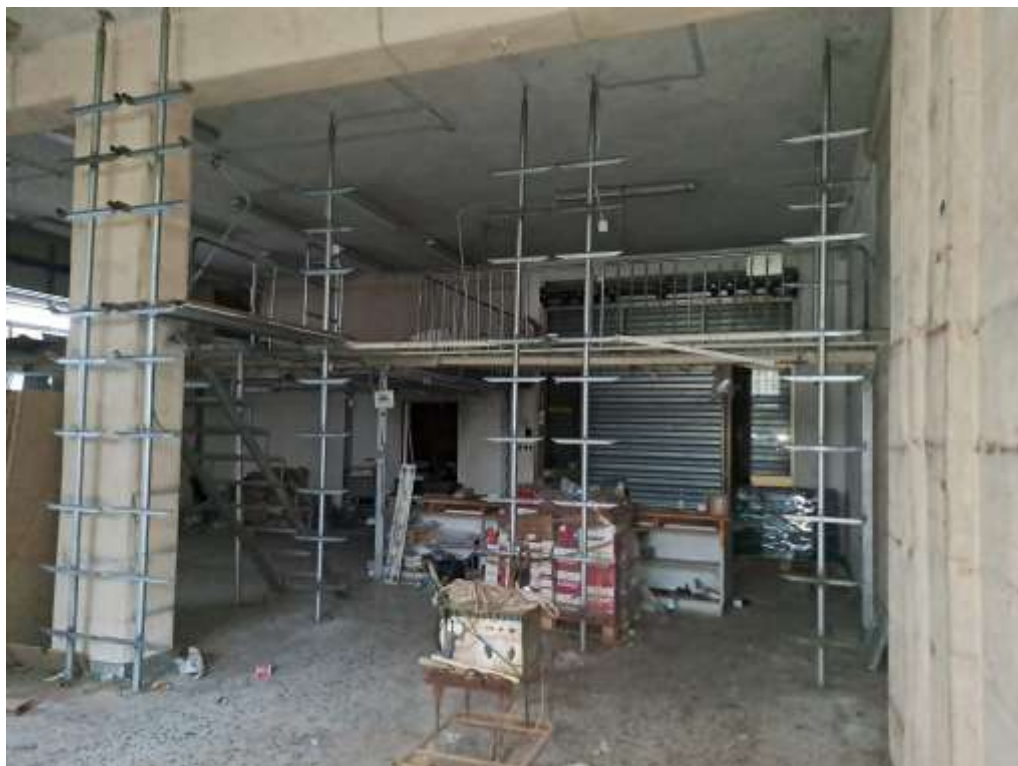
Fig. 21_ Foto interna manufatto_Corpo 1_locale commerciale P.T.
