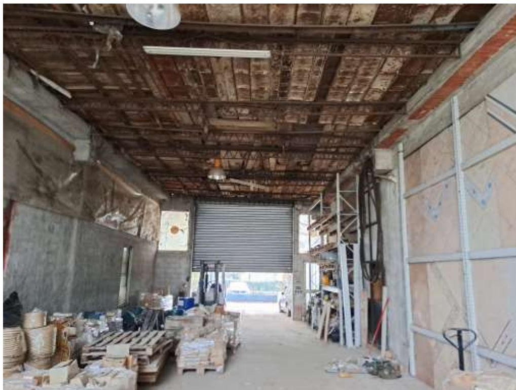
Fig. 20_ Foto interna manufatto_Corpo 1_sottopassaggio P.T.
