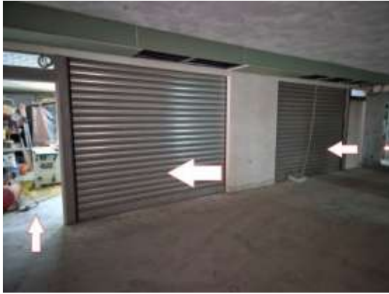
Figura 7 accesso al box auto con wc e deposito al piano seminterrato
