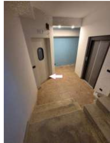
Figura 4 ingresso al piano seminterrato dal vano scala comune del fabbricato
