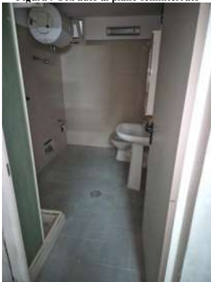
Figura 11 wc interno al box al piano seminterrato
