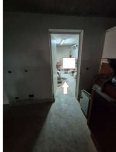
Figura 8 accesso al deposito annesso al box al piano seminterrato
