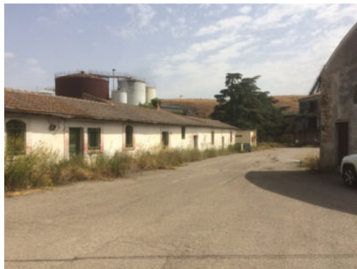
Fabbricato U – prospetto anteriore
