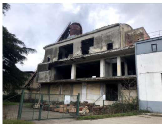
Fabbricato Q – prospetto principale
