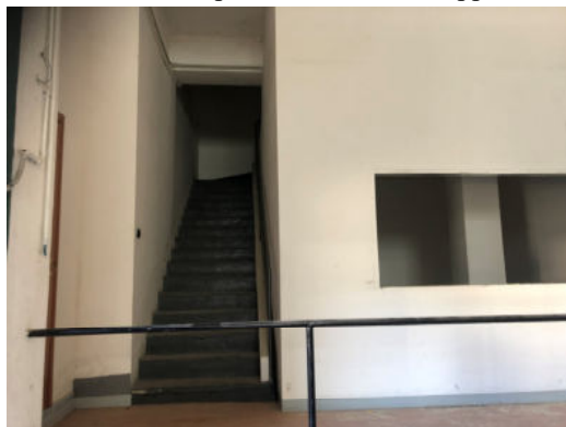
Fabbricato P – interno gradinata
