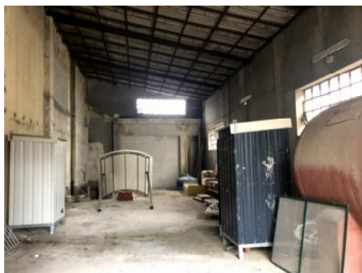
Fabbricato G –sub 10
