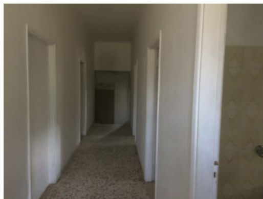
Fabbricato Uffici e casa custode interno
