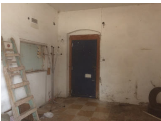
Fabbricato Uffici e casa custode interno
