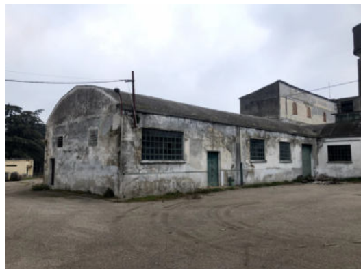
Fabbricato L– sub 10
