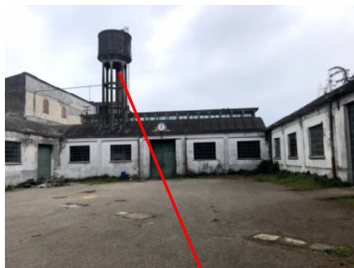
Fabbricato A – serbatoio
