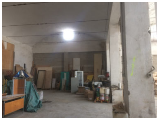
Fabbricato A - interno
