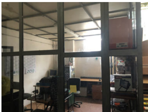
Fabbricato L – interno
