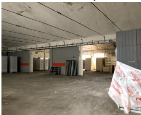
Fabbricato O –interno piano terra
