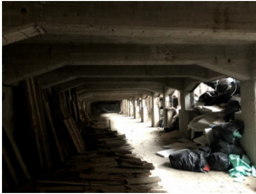
Fabbricato H –interno piano seminterrato
