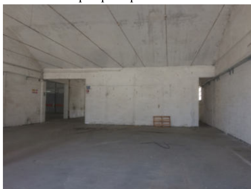
Fabbricato N – interno piano terra
