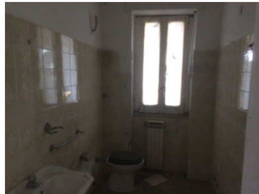
Fabbricato Uffici e casa custode interno
