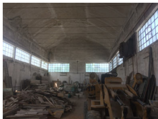
Fabbricato H – interno piano terra
