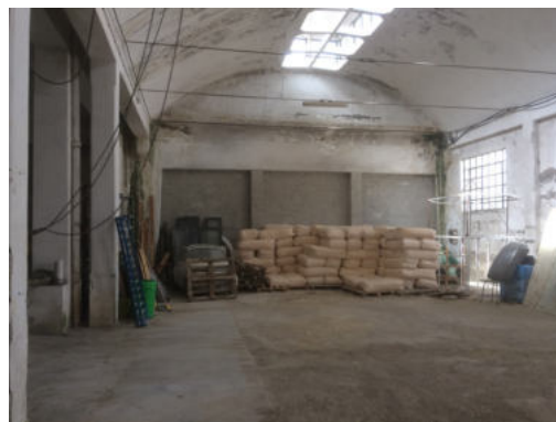
Fabbricato A - interno
