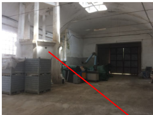
Fabbricato A – struttura esagonale
