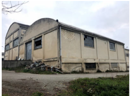
Fabbricato I – sub 10
