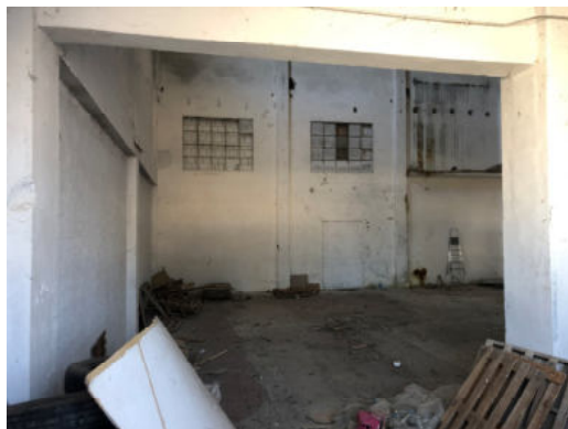
Fabbricato F –sub 9
