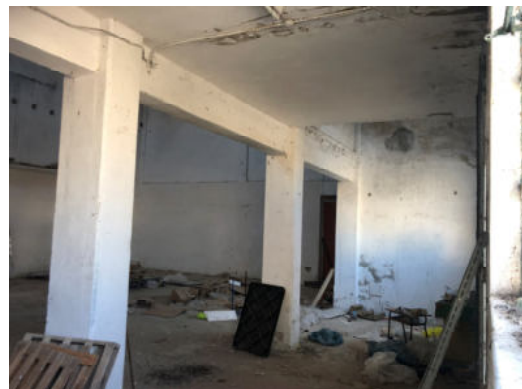
Fabbricato F – vista su prospetto anteriore
