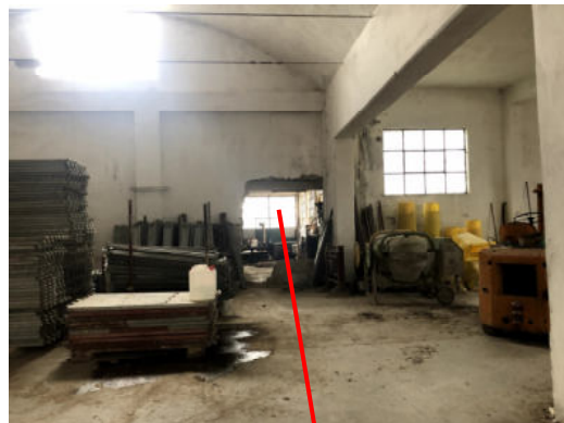
Fabbricato S – accesso al fabbricato B
