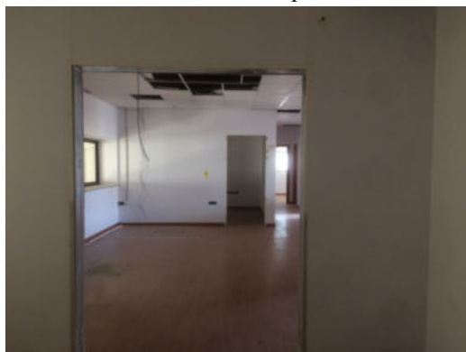
Fabbricato P –interno piano soppalcato - uffici
