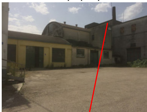
Fabbricato E – vista su prospetto anteriore
