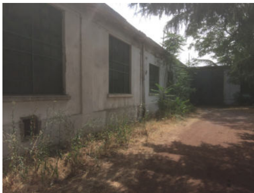
Fabbricato S – prospetto laterale destro ed accesso
