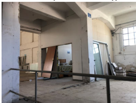
Fabbricato P –piano terra – vista soppalco
