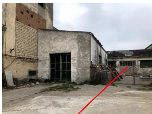
Fabbricato N – prospetto posteriore
