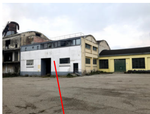
Fabbricato P – prospetto principale
