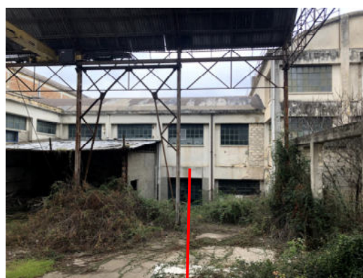
Fabbricato O – prospetto laterale sinistro
