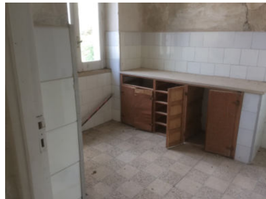
Fabbricato Uffici e casa custode interno
