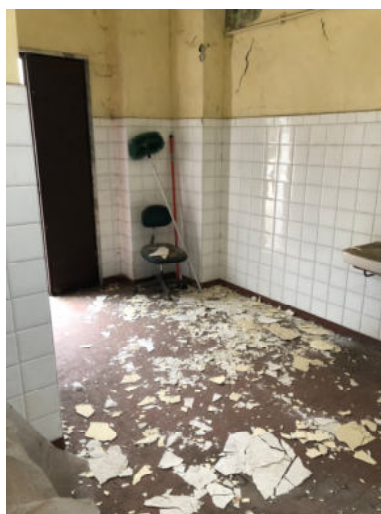
Fabbricato L – antibagno
