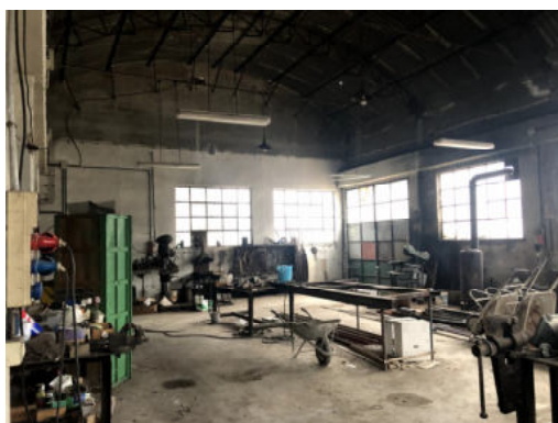
Fabbricato B – interno
