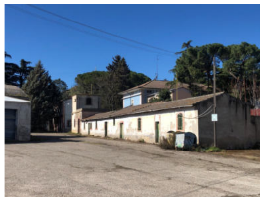
Fabbricato Uffici e casa custode dalla corte
