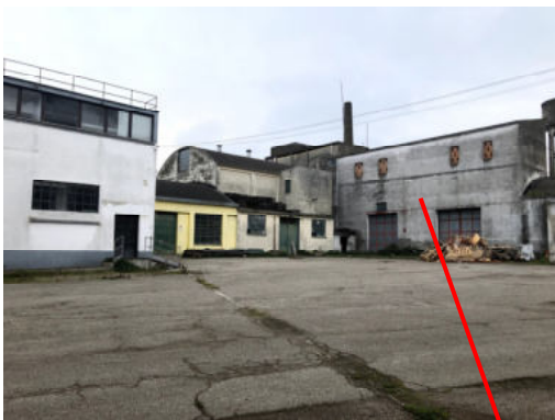
Fabbricato A1 - prospetto principale
