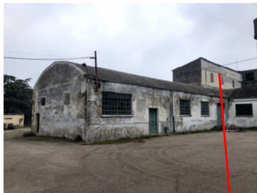
Fabbricato A – prospetto posteriore
