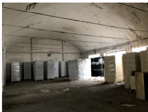
Fabbricato N – interno piano terra
