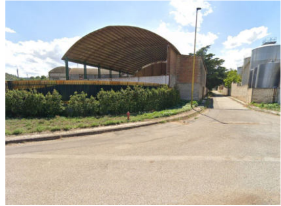
Accesso dalla strada Comunale
