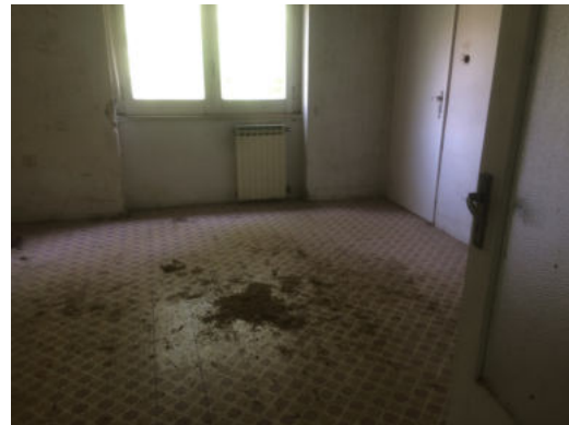
Fabbricato Uffici e casa custode interno
