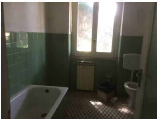
Fabbricato Uffici e casa custode interno
