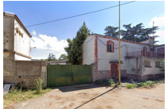
Accesso sul prospetto principale
