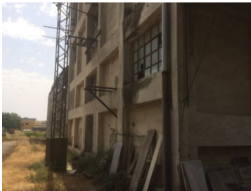
Fabbricato Q – prospetto laterale
