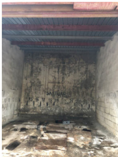
Fabbricato M – interno
