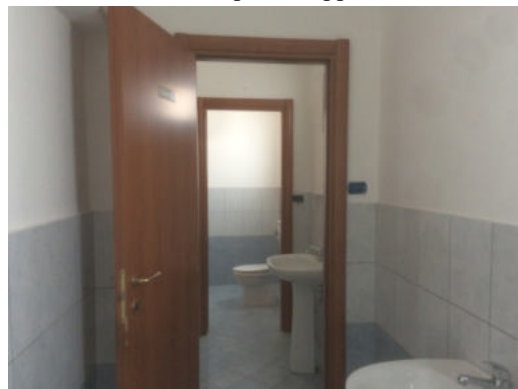
Fabbricato P – interno piano soppalcato servizi igienici
