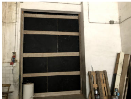
Fabbricato D – interno
