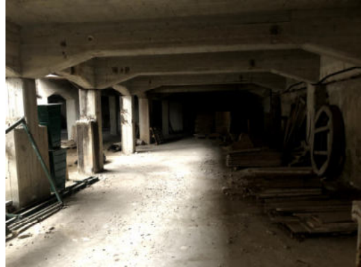
Fabbricato H –interno piano seminterrato
