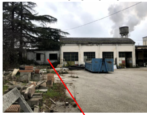
Fabbricato S – prospetto posteriore
