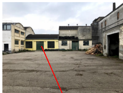
Fabbricato N – prospetto anteriore
