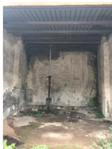
Fabbricato M– interno
