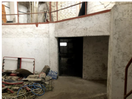
Fabbricato E – interno
