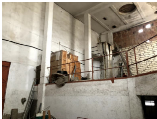
Fabbricato E – interno
