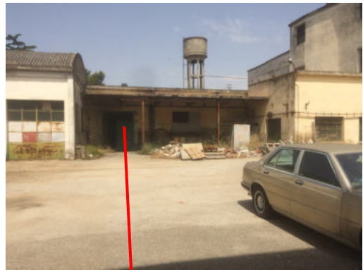
Fabbricato C – accesso su prospetto posteriore
