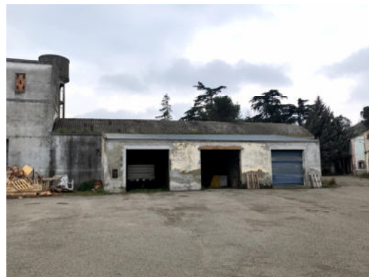
Fabbricato M– sub 10
