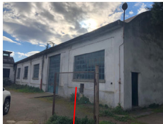
Fabbricato R – prospetto principale
