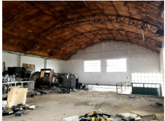
Fabbricato I – interno
