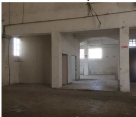
Fabbricato P – interno piano terra
