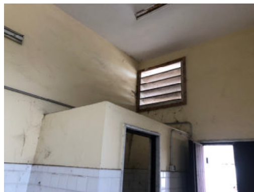
Fabbricato L – bagno
