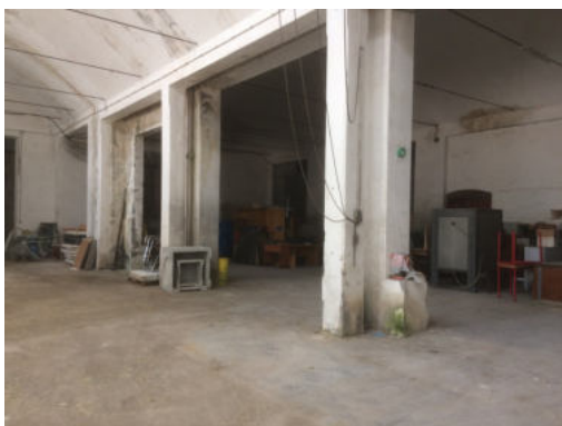
Fabbricato A - interno
