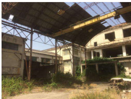
Tettoia T2 - interno
