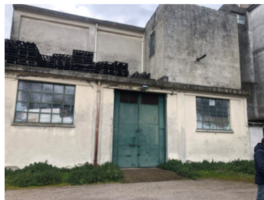
Fabbricato F – vista su prospetto anteriore
