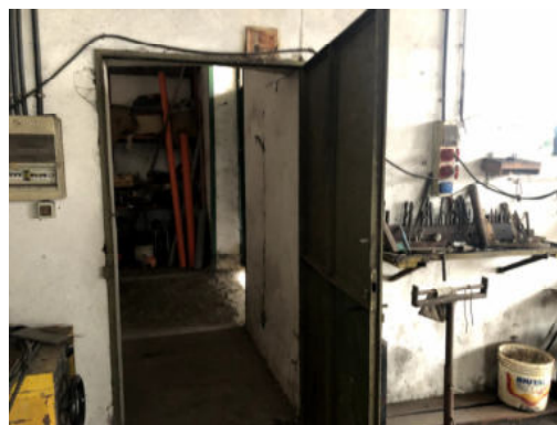
Fabbricato B – porta di accesso al fabbricato C
