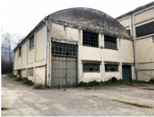
Fabbricato I –sub 10
