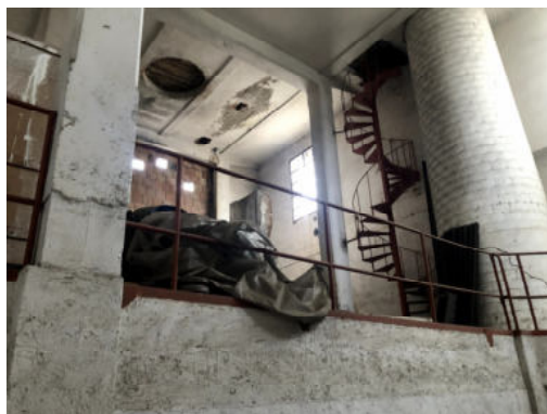
Fabbricato E – interno
