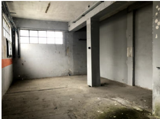
Fabbricato H – interno
