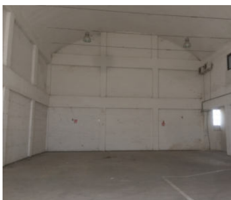
Fabbricato P – interno piano terra
