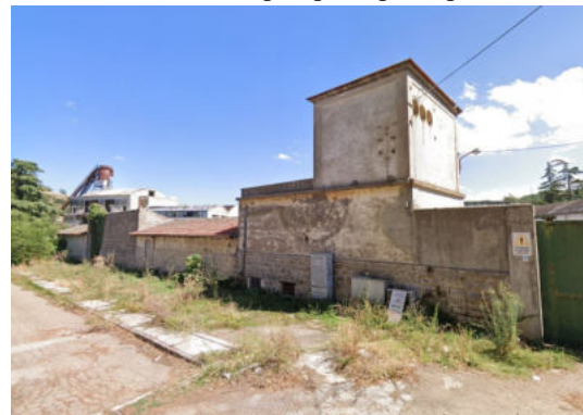
Fabbricato U – prospetto posteriore dalla strada
