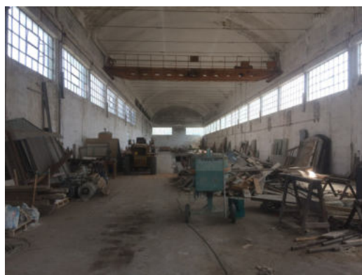
Fabbricato H –interno piano terra
