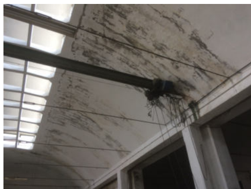
Fabbricato A - interno
