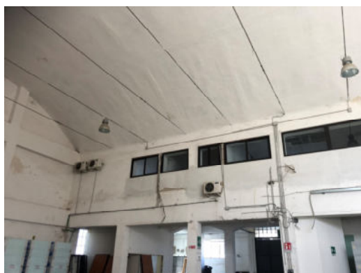
Fabbricato P – piano terra – vista soppalco
