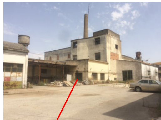
Fabbricato D – accesso su prospetto posteriore
