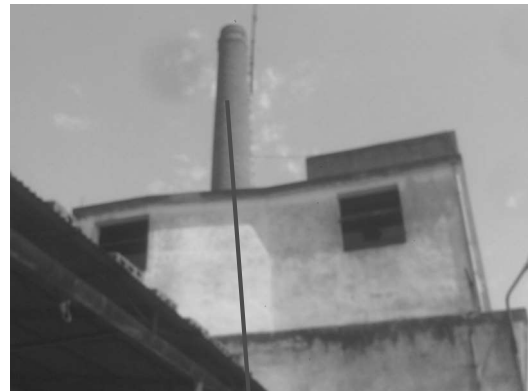
Fabbricato E – particolare ciminiera
