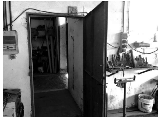
Fabbricato C – porta di accesso dal fabbricato B
