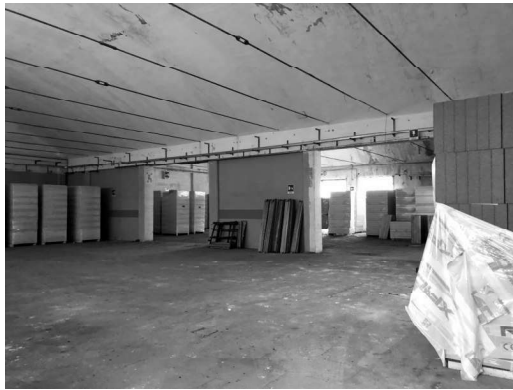
Fabbricato O –interno piano terra
