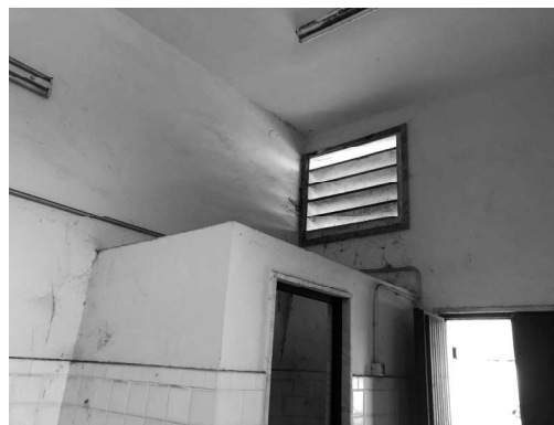
Fabbricato L – bagno
