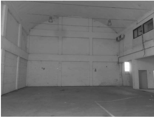
Fabbricato P – interno piano terra
