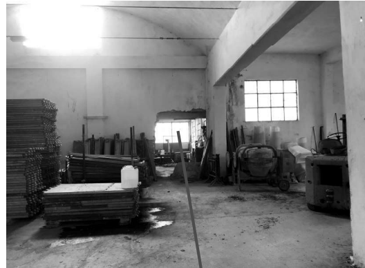
Fabbricato S – accesso al fabbricato B
