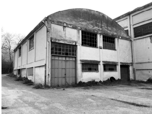
Fabbricato I –sub 10
