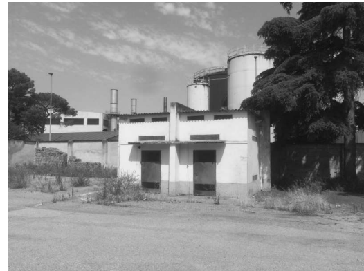
Fabbricato V – prospetto principale
