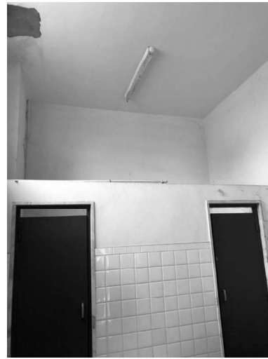
Fabbricato L – bagni
