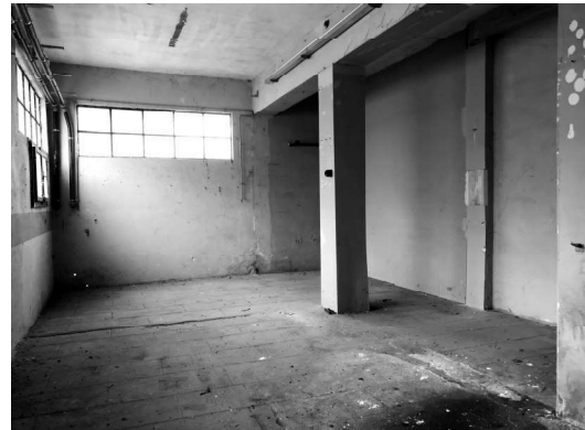
Fabbricato H – interno
