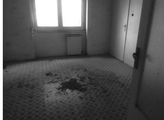
Fabbricato Uffici e casa custode interno
