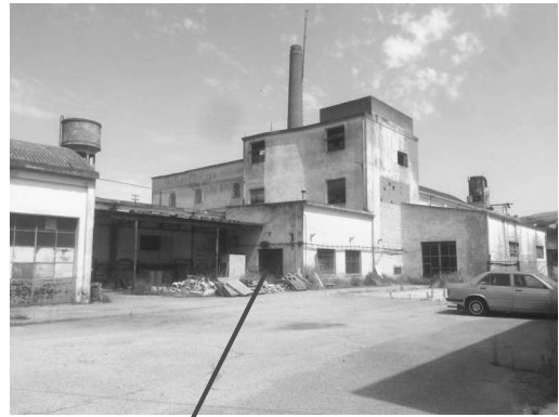
Fabbricato D – accesso su prospetto posteriore
