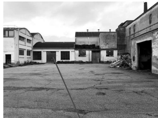
Fabbricato N – prospetto anteriore
