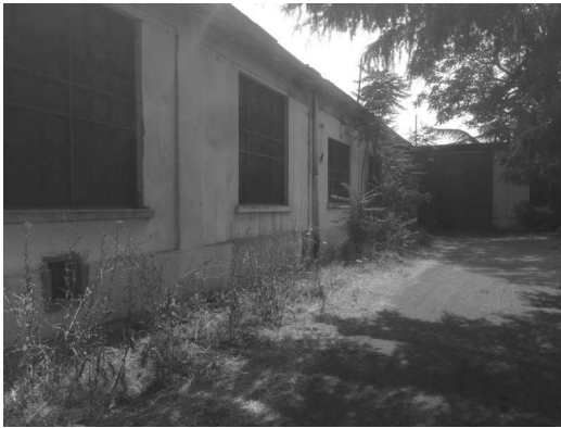
Fabbricato S – prospetto laterale destro ed accesso
