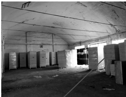
Fabbricato O – interno
