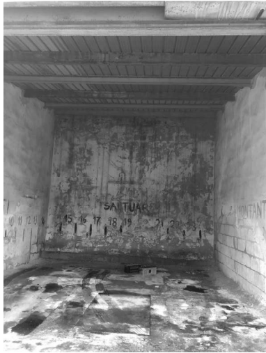
Fabbricato M – interno
