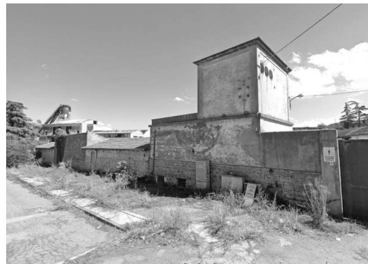
Fabbricato U – prospetto posteriore dalla strada
