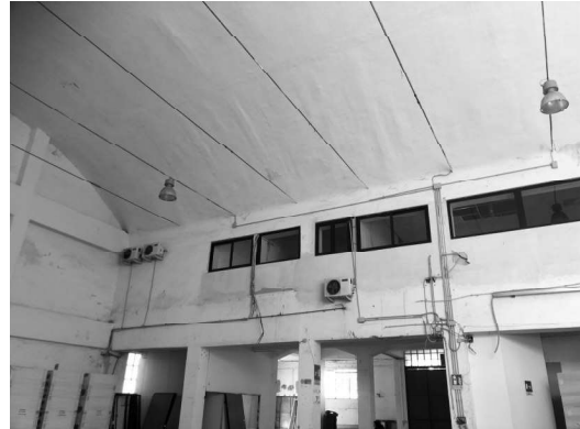
Fabbricato P – interno piano terra – vista soppalco
