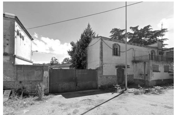
Accesso sul prospetto principale
