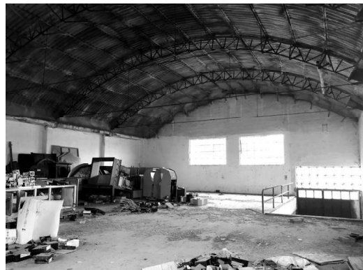
Fabbricato I – interno
