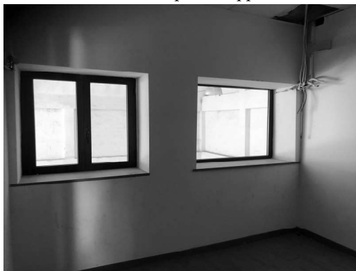
Fabbricato P –interno piano soppalcato - uffici
