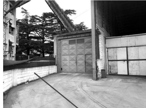
Tettoia T1 – recinzione
