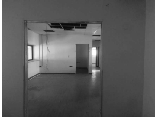
Fabbricato P –interno piano soppalcato - uffici
