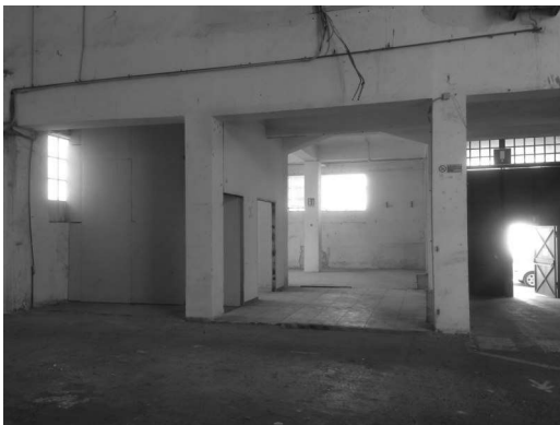
Fabbricato P – interno piano terra
