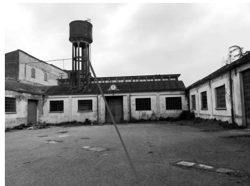
Fabbricato A - serbatoio
