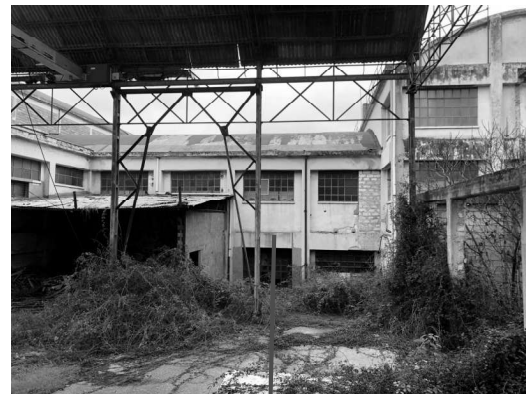
Fabbricato O – prospetto laterale sinistro
