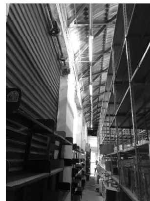
Fabbricato L – interno
