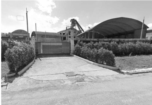
Tettoia T1 – accesso
