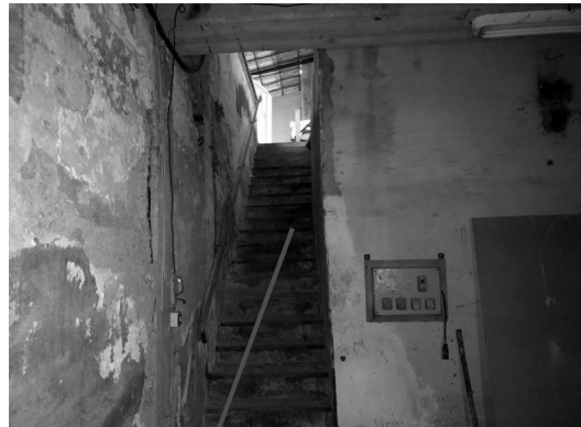
Fabbricato G – scala di accesso al fabbricato N
