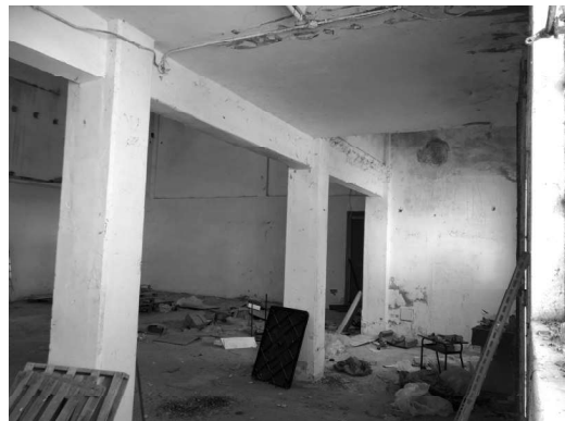
Fabbricato F – vista su prospetto anteriore
