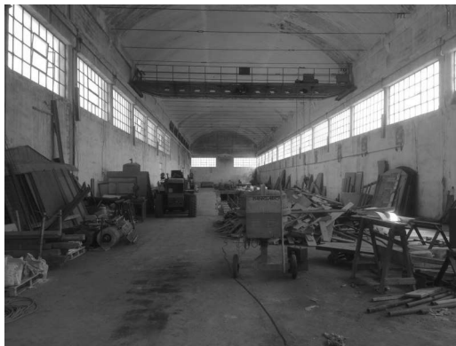
Fabbricato H – interno piano terra
