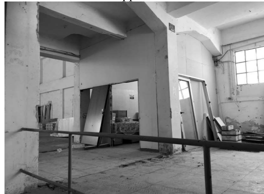
Fabbricato P – interno piano terra – vista soppalco
