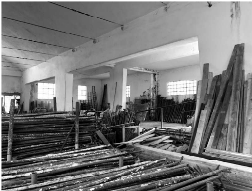
Fabbricato S – interno
