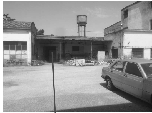
Fabbricato C – accesso su prospetto posteriore
