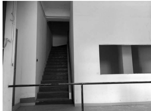
Fabbricato P – interno gradinata
