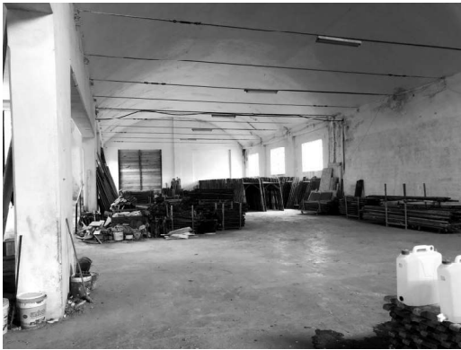
Fabbricato S – interno
