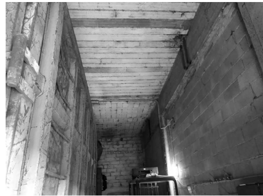
Tettoia T1 – locale altezza 5 mt. - interno
