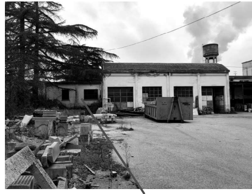
Fabbricato S – prospetto posteriore
