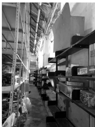
Fabbricato L – interno
