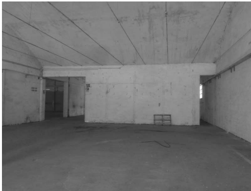
Fabbricato N – interno piano terra
