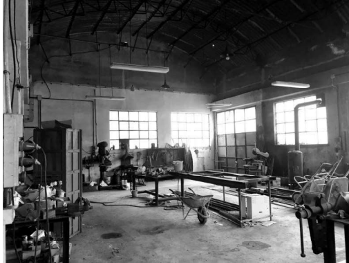
Fabbricato B – interno
