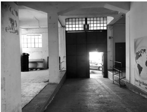
Fabbricato P – interno piano terra
