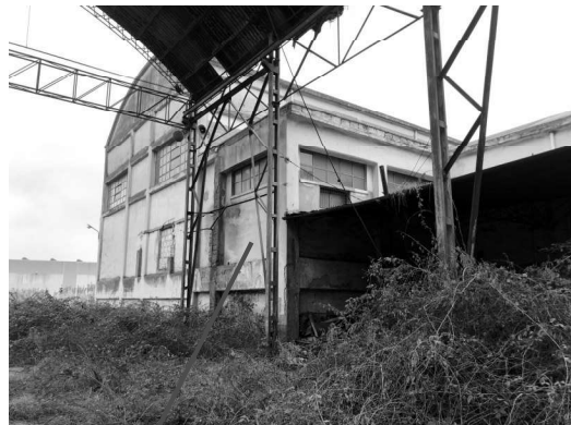
Fabbricato H1 – sub 10
