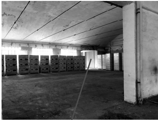
Fabbricato H1 – accesso dal fabbricato O
