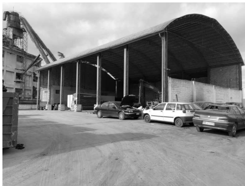
Tettoia T1 – prospetto laterale destro
