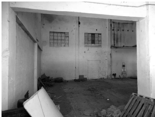
Fabbricato F -sub 9
