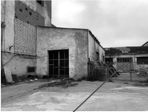
Fabbricato N – prospetto posteriore
