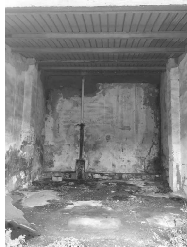
Fabbricato M– interno
