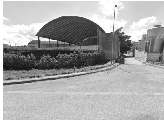
Accesso dalla strada Comunale
