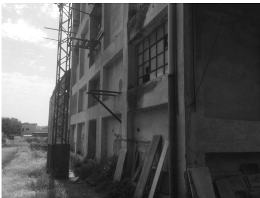
Fabbricato Q – prospetto laterale
