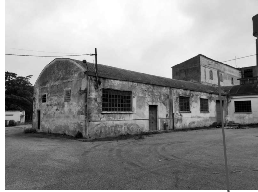
Fabbricato A – prospetto posteriore
