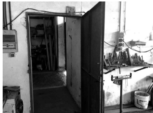
Fabbricato B – porta di accesso al fabbricato C
