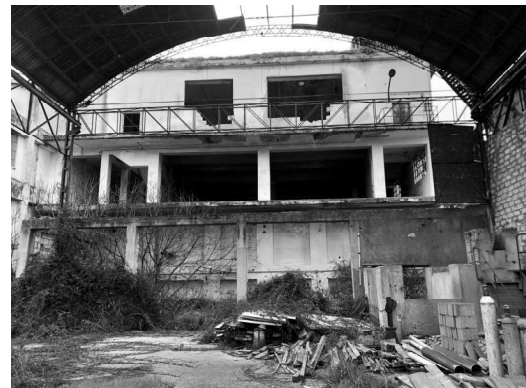
Fabbricato Q – prospetto posteriore
