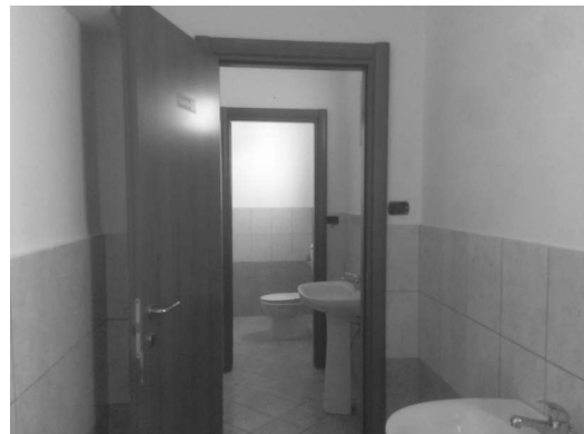
Fabbricato P – interno piano soppalcato servizi igienici
