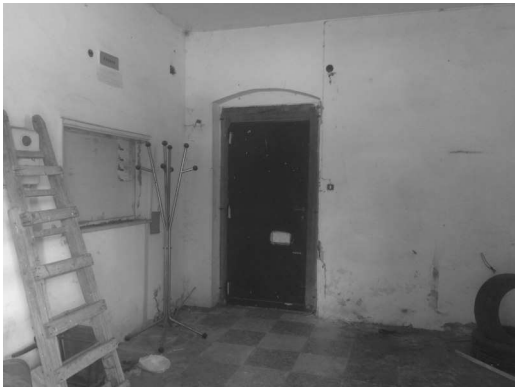
Fabbricato Uffici e casa custode interno
