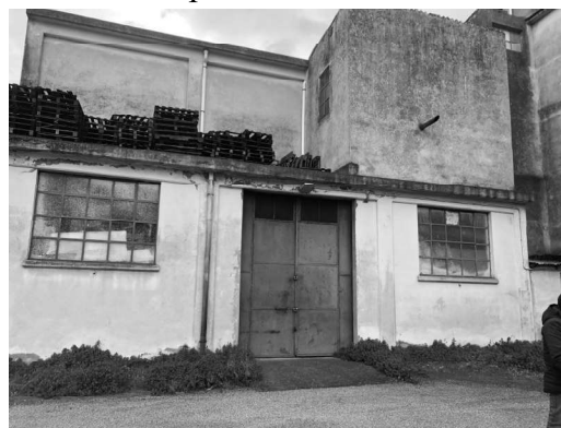
Fabbricato F – vista su prospetto anteriore
