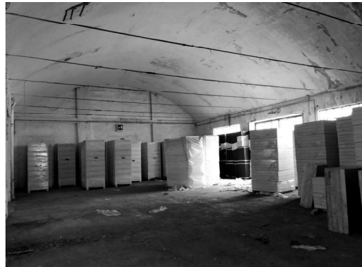
Fabbricato N – interno piano terra
