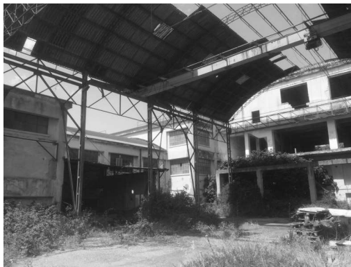
Tettoia T2 - interno
