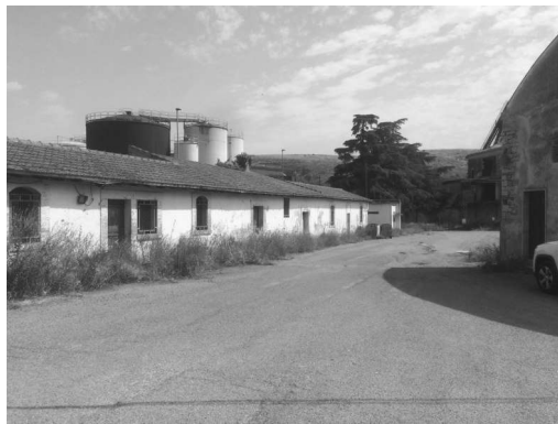
Fabbricato U – prospetto anteriore
