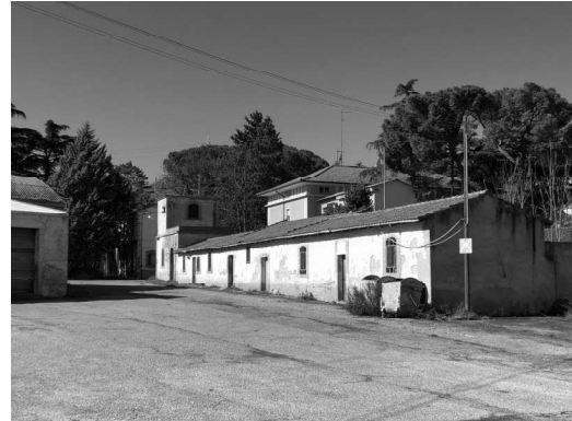
Fabbricato Uffici e casa custode dalla corte
