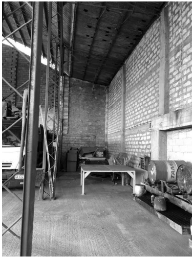
Tettoia T1 – interno
