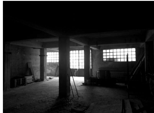
Fabbricato O – interno piano terra
