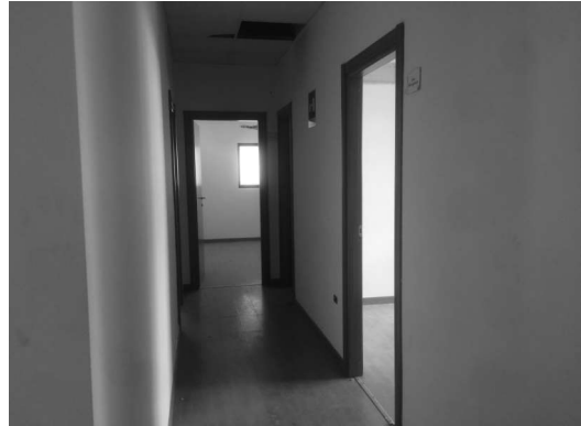
Fabbricato P – interno piano soppalcato - uffici
