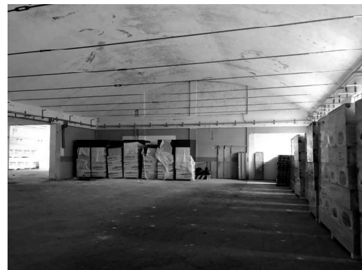
Fabbricato O - interno
