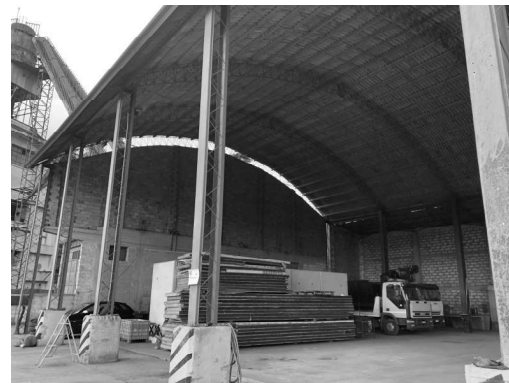
Tettoia T1 – prospetto laterale sinistro
