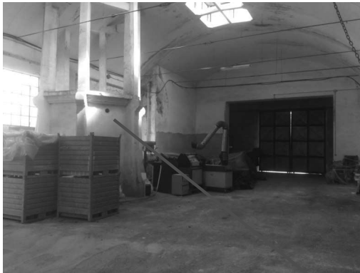
Fabbricato A – struttura esagonale
