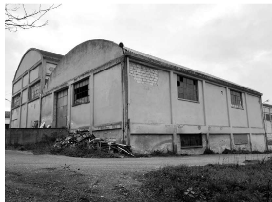
Fabbricato I – sub 10
