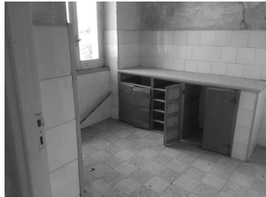
Fabbricato Uffici e casa custode interno
