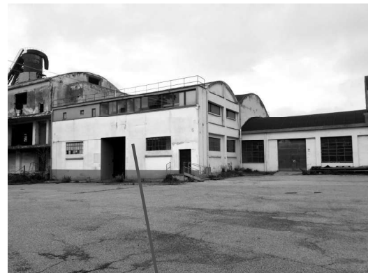
Fabbricato P – prospetto principale
