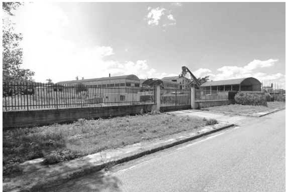
Prospetto laterale sinistro e posteriore
