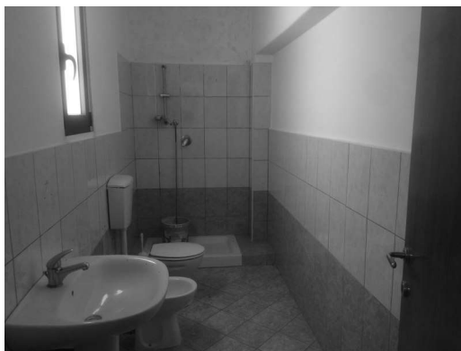
Fabbricato P – interno piano soppalcato servizi igienici
