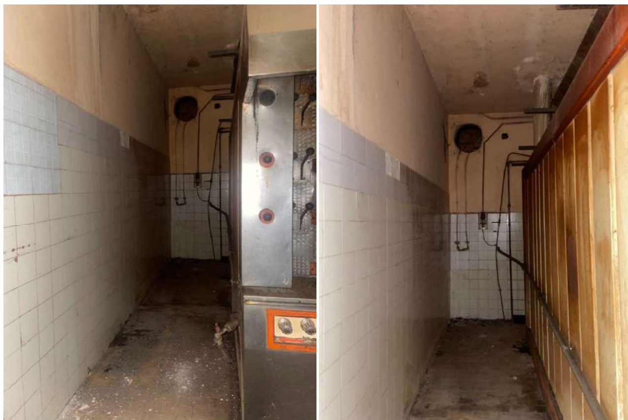
Figura 15 - 16: VISTE ZONA FORNO DI DESTRA
