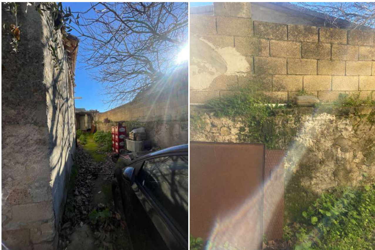
Figura 40 - 41: CAMMINAMENTO DI INGRESSO SUL RETRO – DETTAGLIO MURO DI CONFINO
