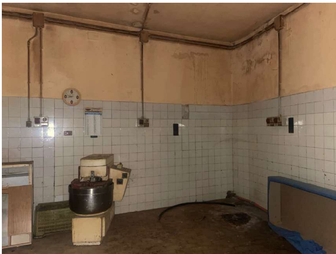
Figura 30-31: DETTAGLI INTERNI ZONA PANIFICAZIONE
