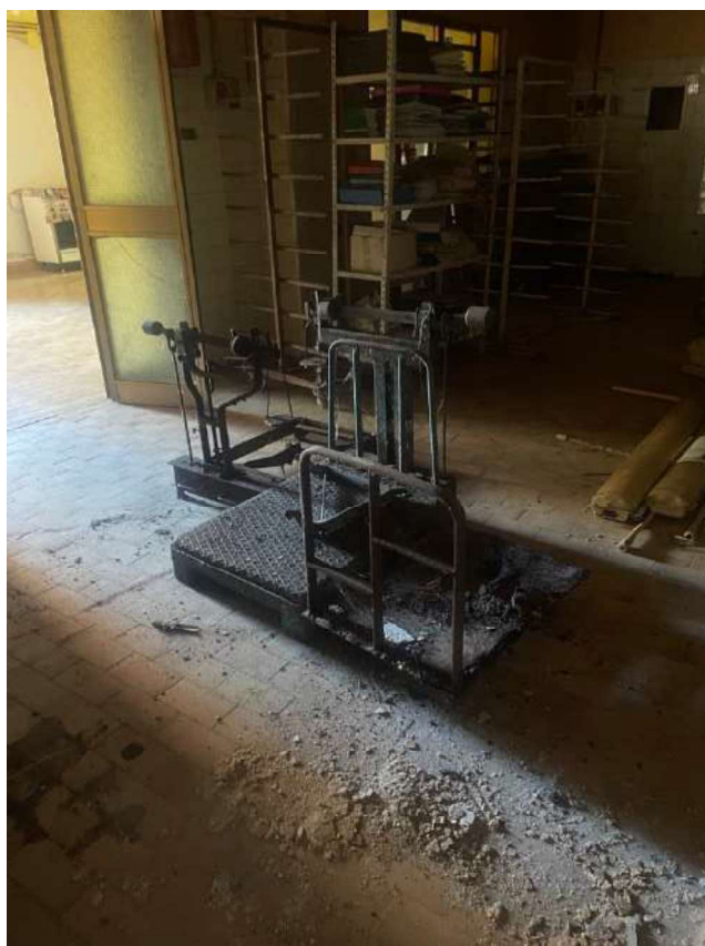
Figura 34 - 36: DETTAGLI INTERNI ZONA PANIFICAZIONE- ATTREZZATURE E FORNITURE
