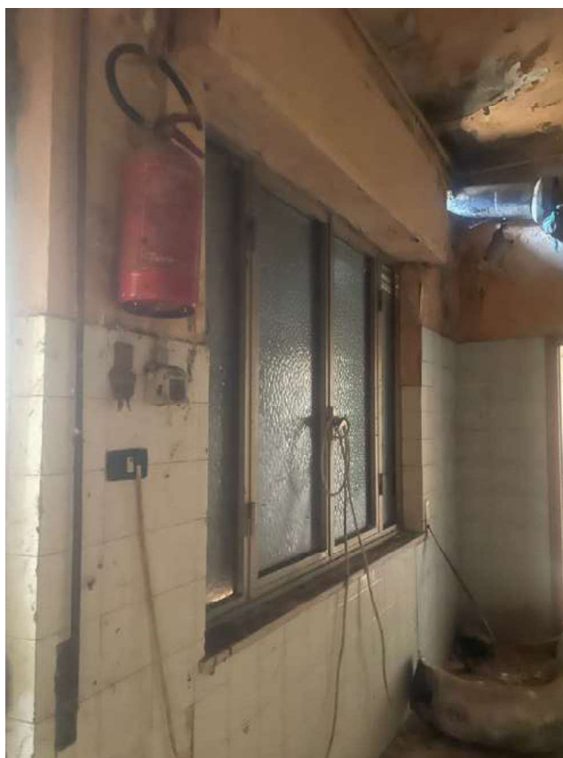
Figura 21: VISTA INFISSO FINESTRATO SUL RETRO
