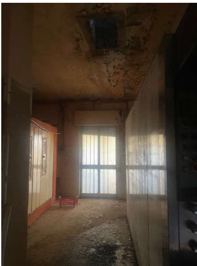
Figura 46 - 48: DETTAGLIO INFILTRAZIONI SUL FORNO DI DESTRA ( PER CHI ACCEDE AL BENE DALL'INGRESSO PRINCIPALE)
