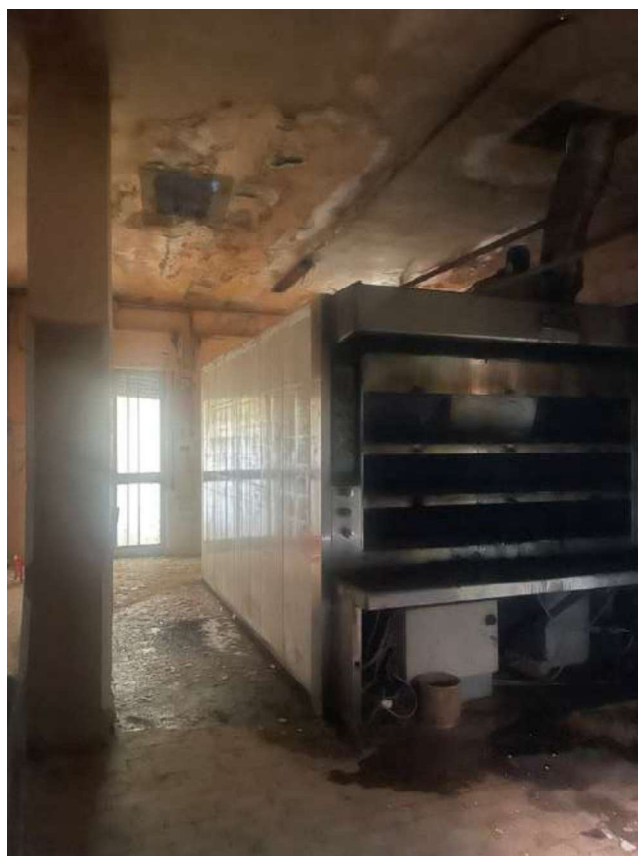
Figura 46 - 48: DETTAGLIO INFILTRAZIONI SUL FORNO DI DESTRA ( PER CHI ACCEDE AL BENE DALL'INGRESSO PRINCIPALE)
