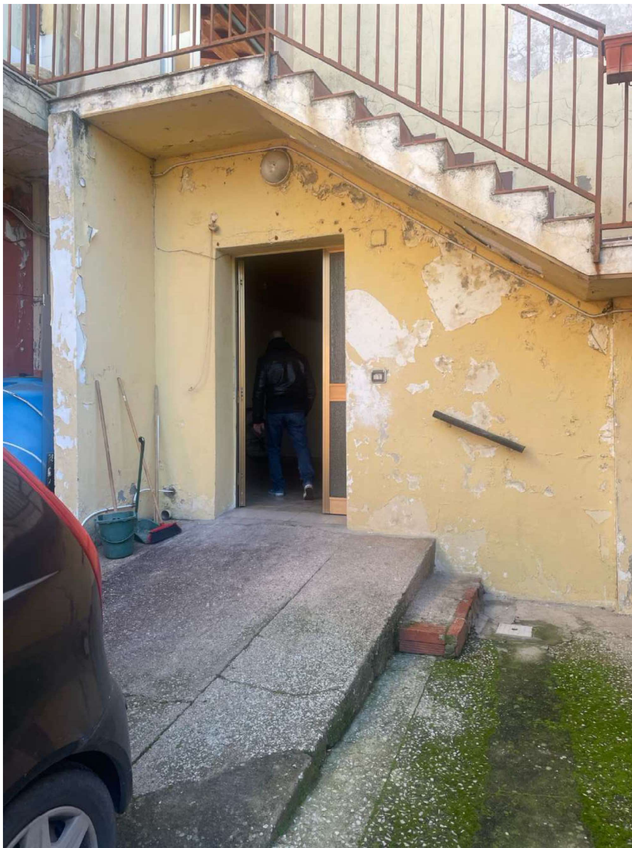
Figura 60: DETTAGLIO AMMALORAMENTO DEL PROPSETTO PRINCIPALE
