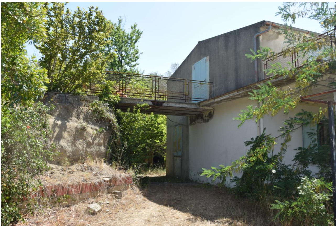
Passarella di accesso al Primo Piano
