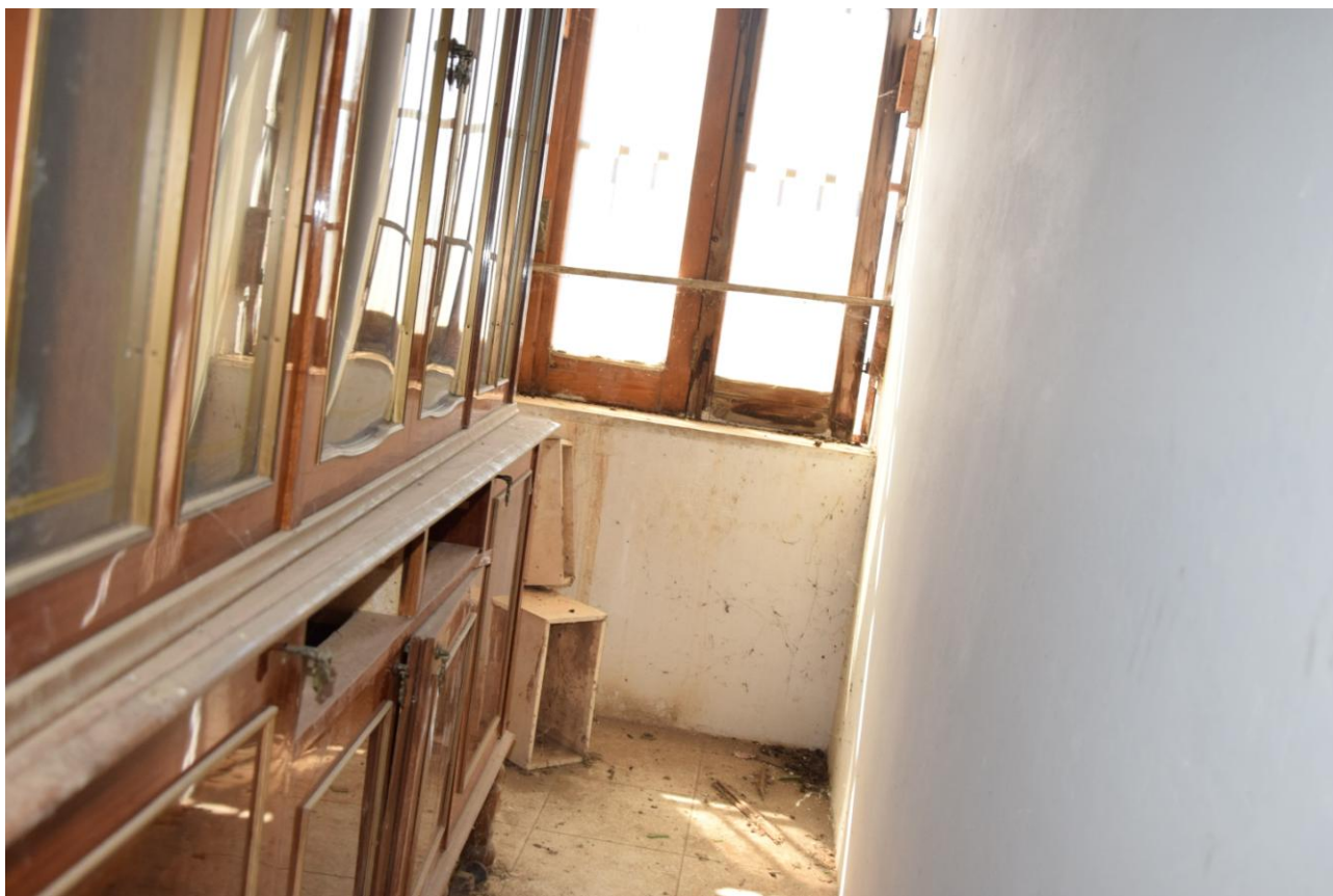
Vista Disimpegno Piano primo
