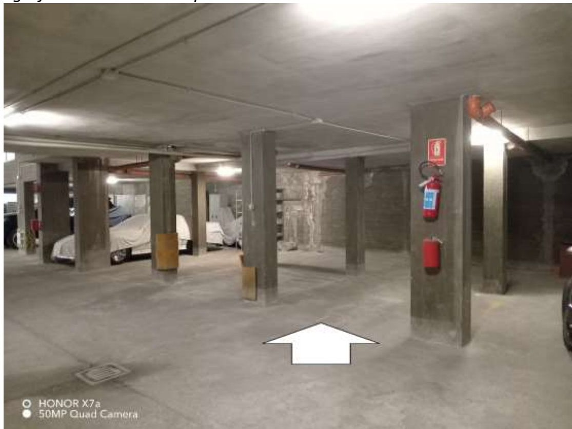
Fotografia n. 1 – Accesso al posto auto 13
