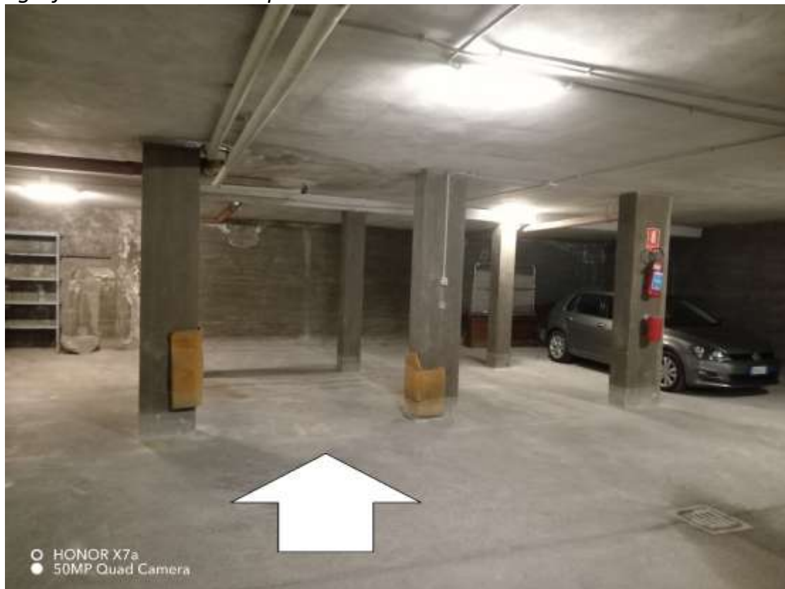
Fotografia n. 3 – Accesso al posto auto 14
