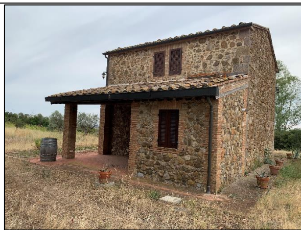
Prospetto est e in parte nord
