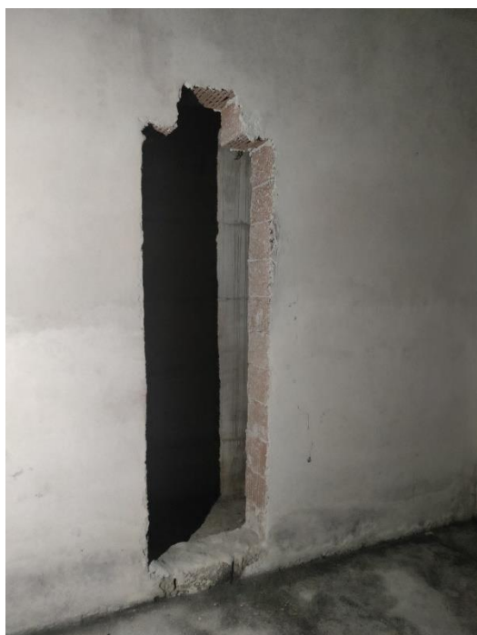
Foto 56: apertura C di accesso al locale interrato
